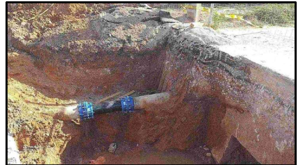
Fotografía nº 4. Reparación mediante sustitución PE250 a Guadassuar
