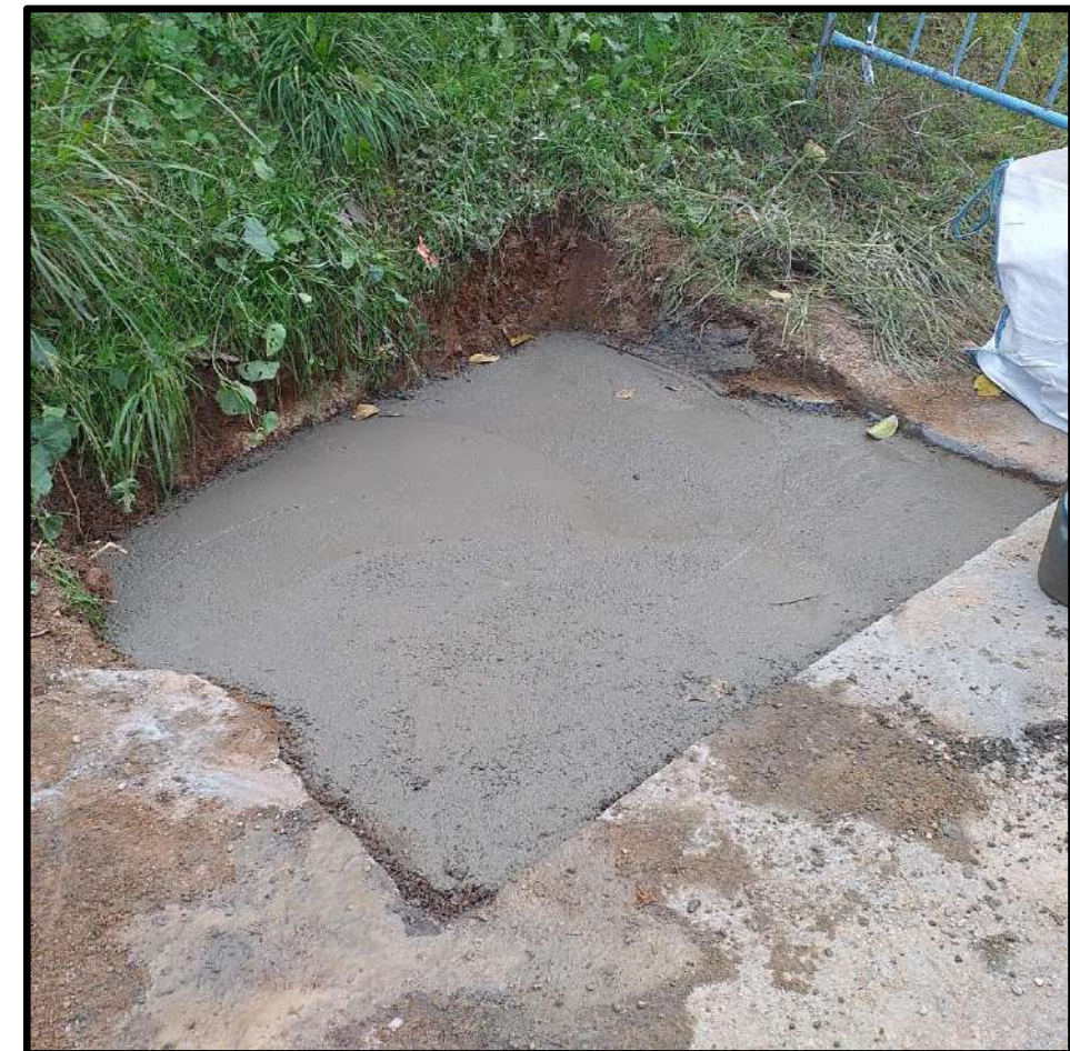
Fotografía nº 2. Reparación en tubería afectada
