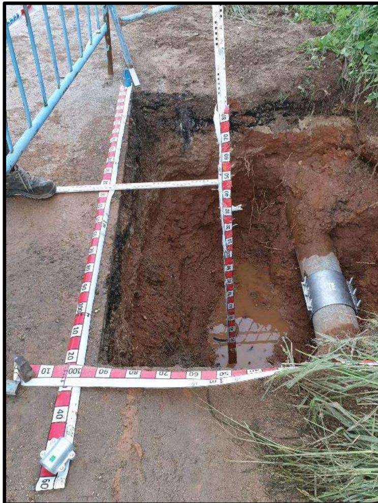
Fotografía nº 1. Reparación en tubería afectada
