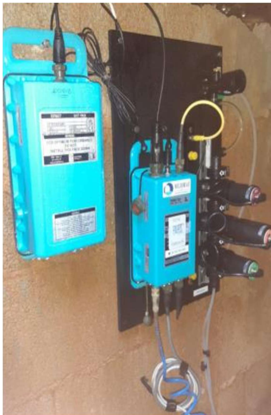
4.- Instalación de nuevo Turbidímetro
