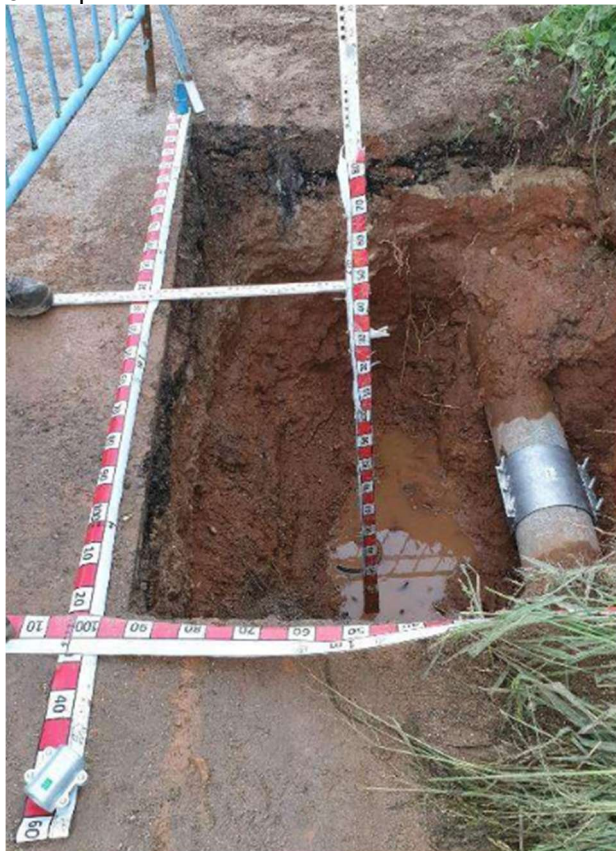
3.- Reparación tubería de fibrocemento
