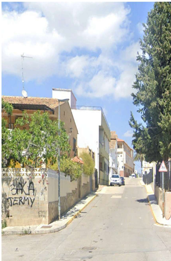
10.-Vista General actuación Fase 1 saneamiento
