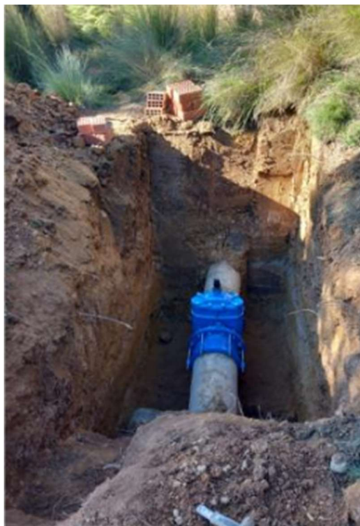
3.- Válvula compuerta tubería de FIBROCEMENTO DN 200 barranco La Baiba
