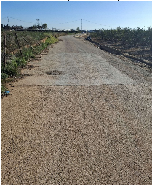
5.- y 6.- Estado reparación tubería FC en la visita 4 de febrero
