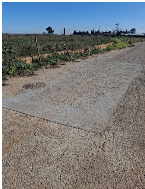
5.- y 6.- Estado reparación tubería FC en la visita 4 de febrero
