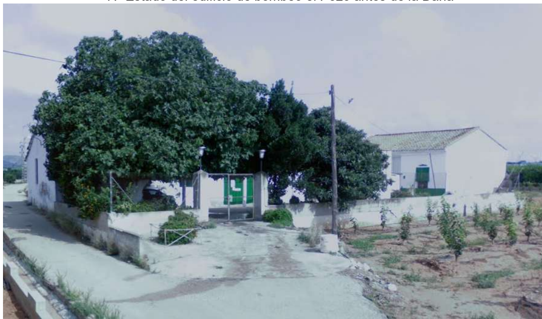
7.- Estado del edificio de bombeo el Pozo antes de la Dana
