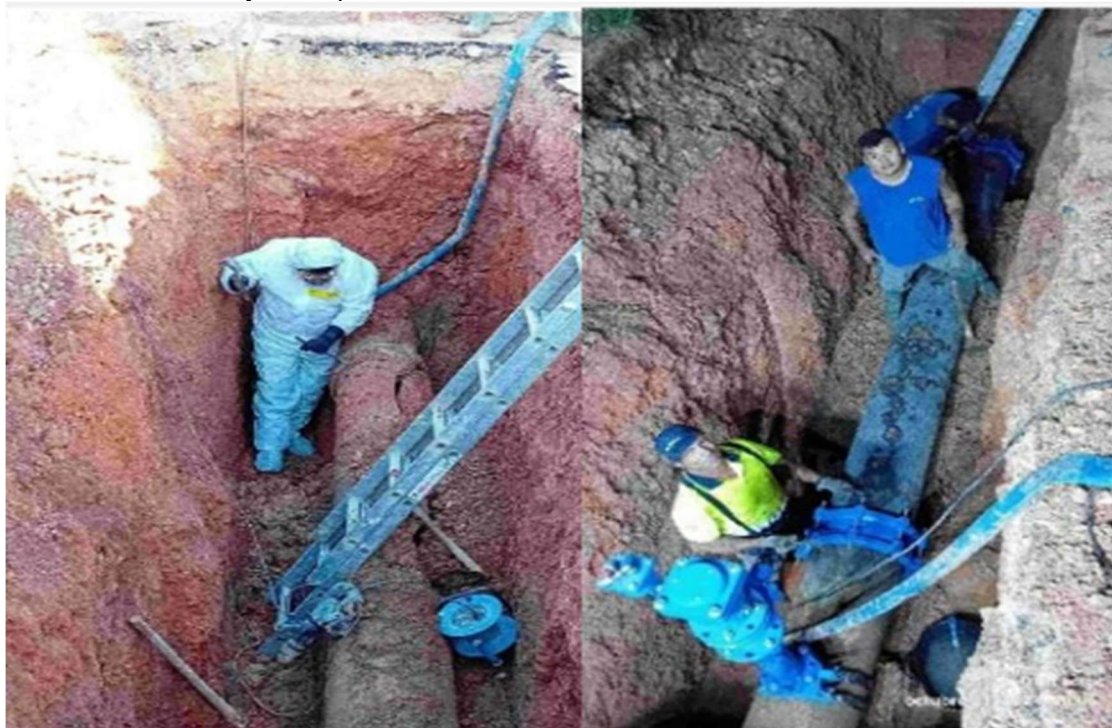
3.- y 4.- Reparación tubería de fibrocemento S.A. La Ribera
