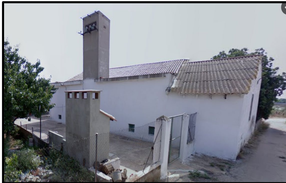
Fotografía nº 2. Estado original. Vista trasera
