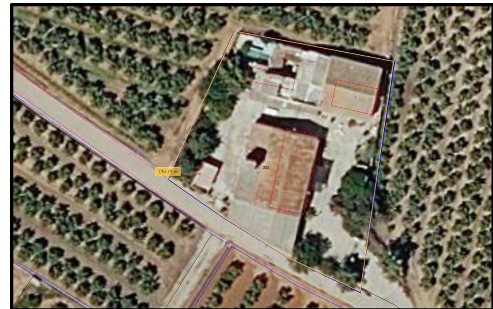
Fotografía nº 8. Longitud cerramiento a reconstruir
