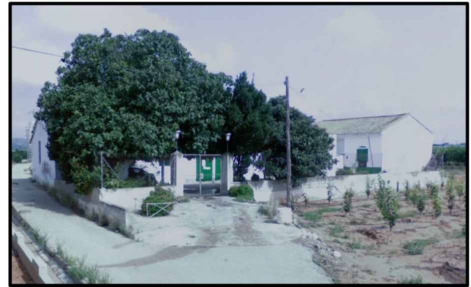
Fotografía nº 3. Estado original. Vista frontal
