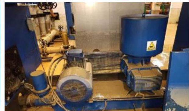
Estado de las soplantes tras la DANA. Fuente: informe EPSAR.
