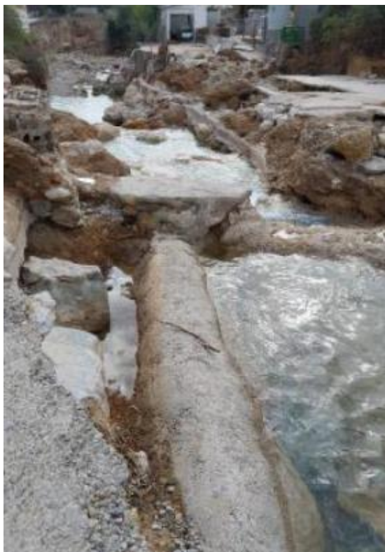
Estado de los colectores tras la DANA. Fuente: informe EPSAR.
