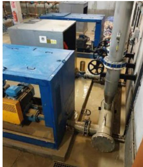
Estado de las conexiones eléctricas y tuberías tras la DANA. Fuente: informe EPSAR.
