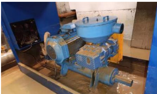
Estado de las soplantes tras la DANA. Fuente: informe EPSAR.
