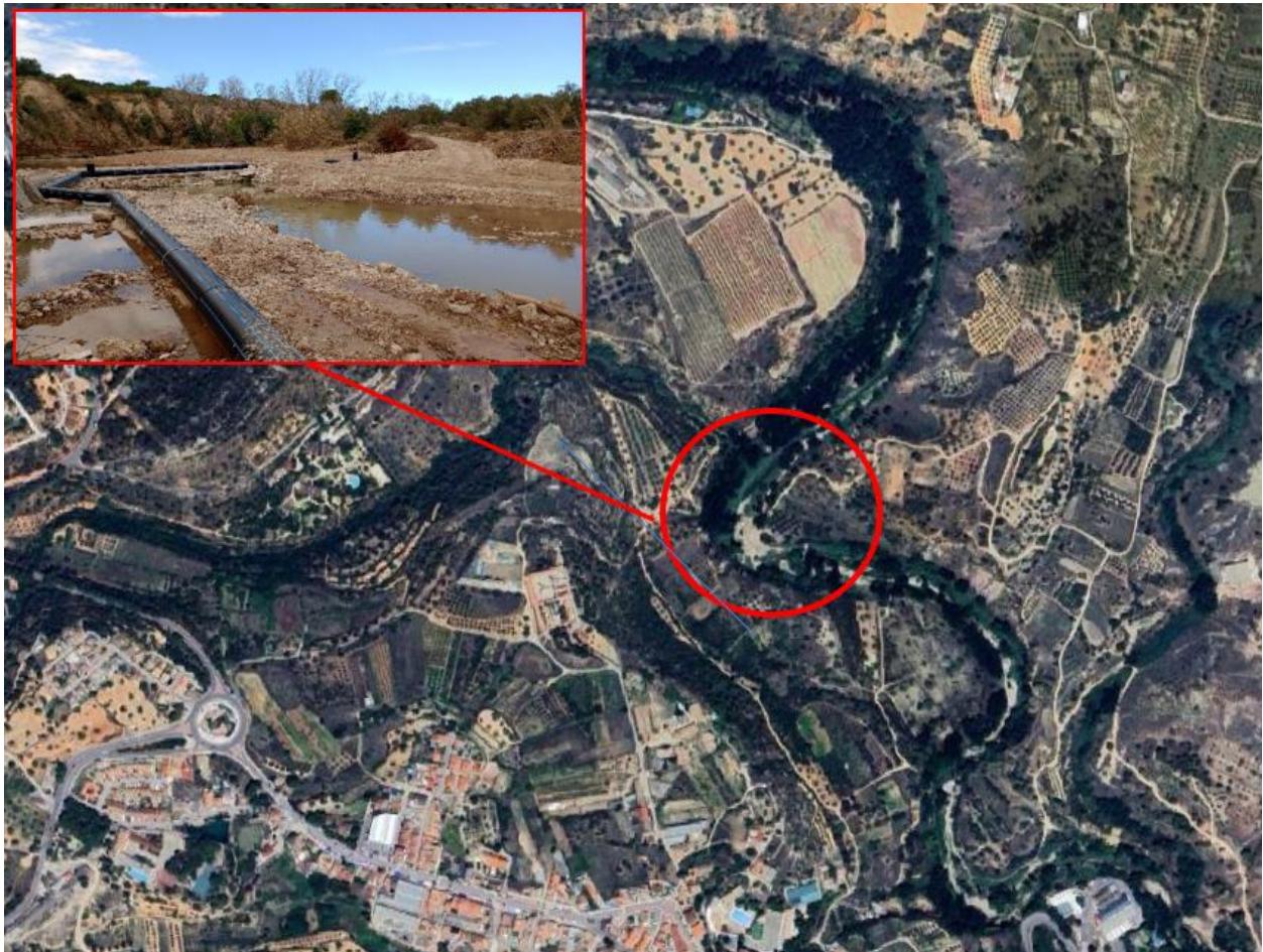
Estado actual del colector. Fuente: Visita (23-01-2025).
