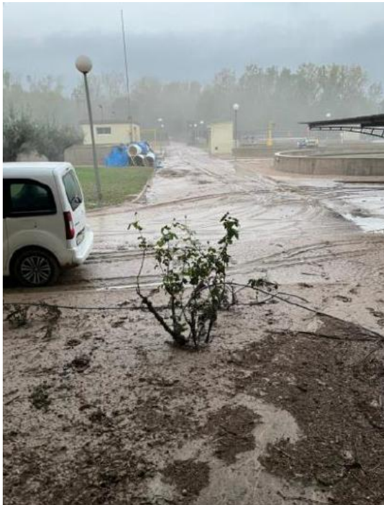
Estado del exterior de la EDAR tras la DANA. Fuente: informe EPSAR.
