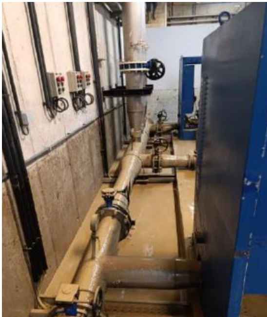
Estado de las conexiones eléctricas y tuberías tras la DANA. Fuente: informe EPSAR.
