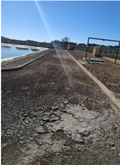
6.-Aspecto de las zonas transitables
