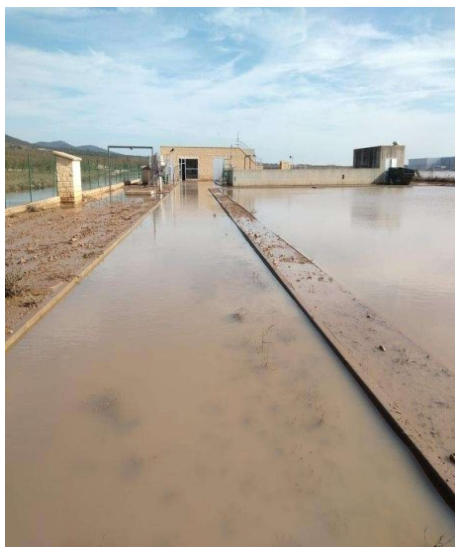
4.-as instalaciones aún están con agua
