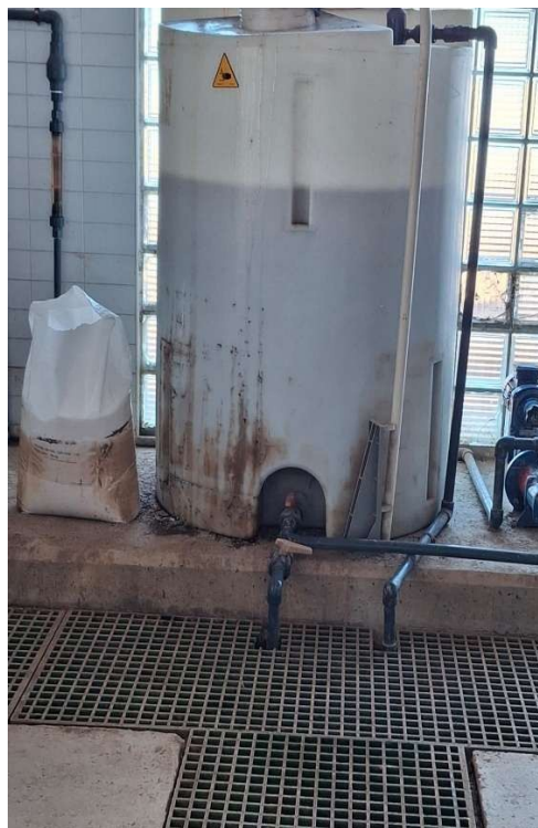
12.- y 13.-Los equipos han quedado inservibles después de tanto tiempo sumergidos
