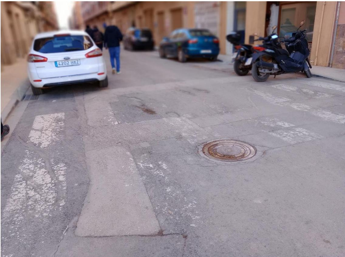
34 C/ MAESTRO MONFORTE. HUNDIMIENTO EN CALZADA
