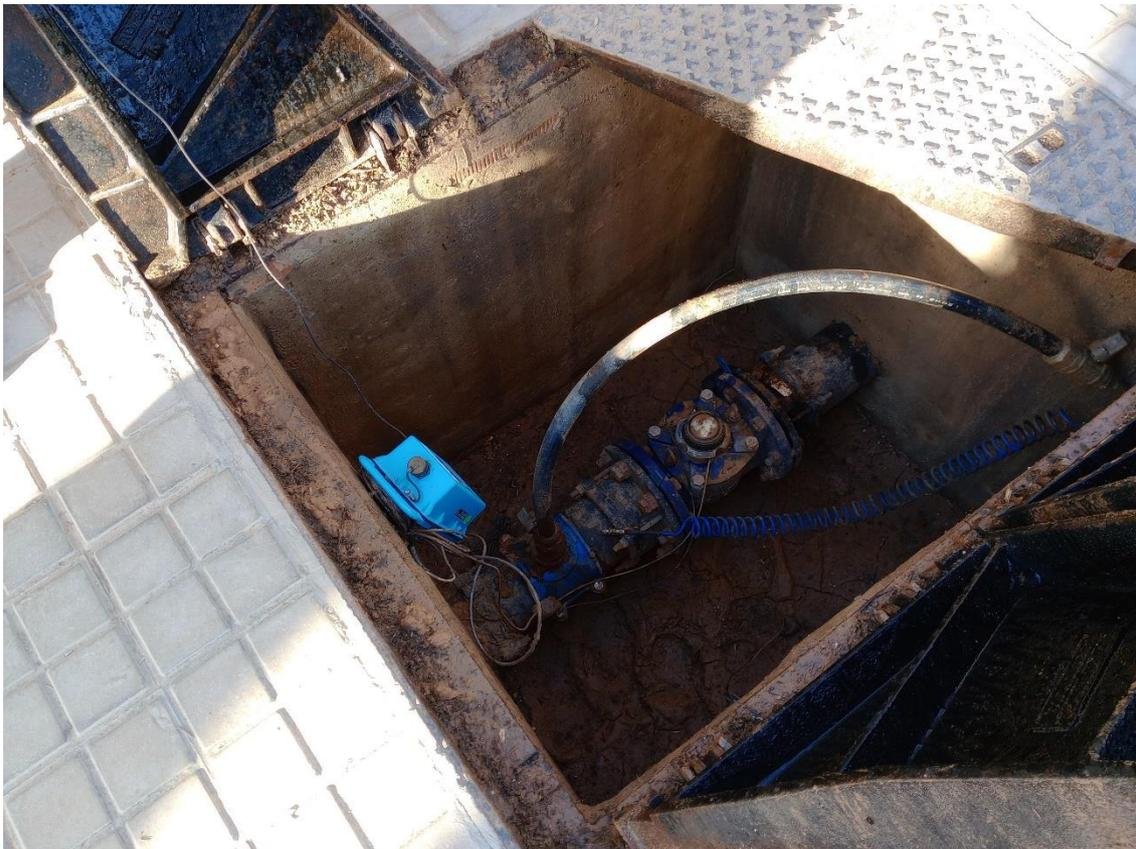
24 AV. RONDA NORTE. CONTADOR SUSTITUIDO EN ARQUETA DE POTABLES (2)
