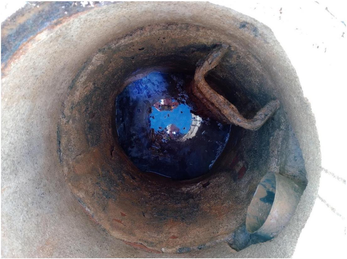
46 CARRER DE LES ANIMES. DETALLE DE ARQUETA DE RESIDUALES EN MAL ESTADO Y PARCIALMENTE COLMATADA
