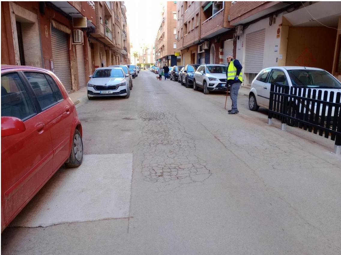
7 C/ ALMERÍA. HUNDIMIENTO EN EL FIRME POR ENCIMA DEL TRAZADO DEL SANEAMIENTO
