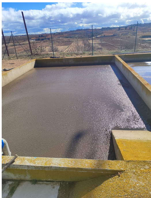
Vista general de las eras de secado de la EDAR. Fuente: Inspección de campo realizada por AMBLING con fecha de 28/01/2025
