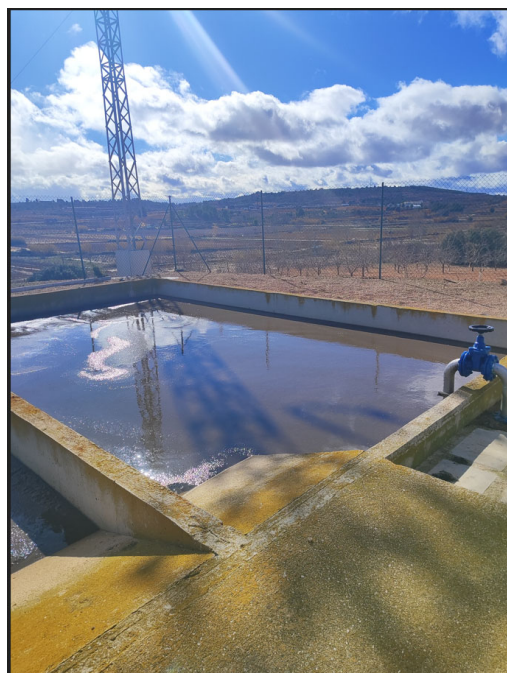
Vista general de las eras de secado de la EDAR. Fuente: Inspección de campo realizada por AMBLING con fecha de 28/01/2025
