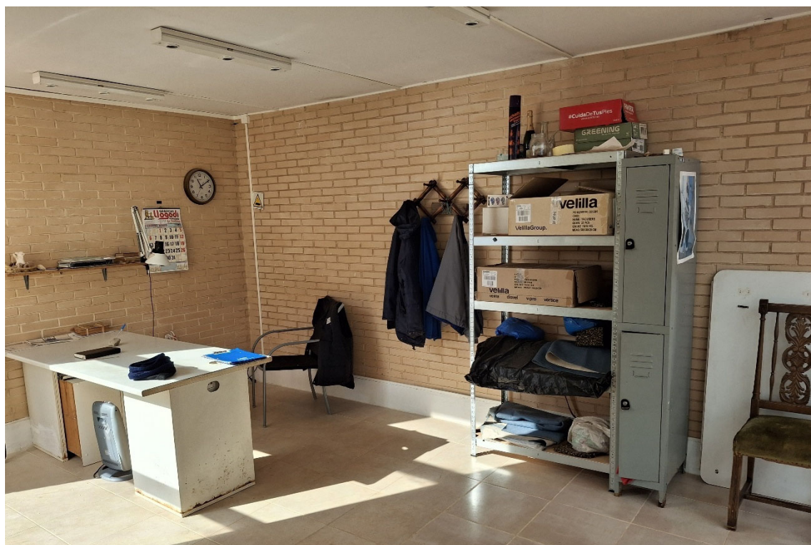
Vista general del interior de la oficina de la EDAR. Fuente: Inspección de campo realizada por AMBLING con fecha de 28/01/2025
