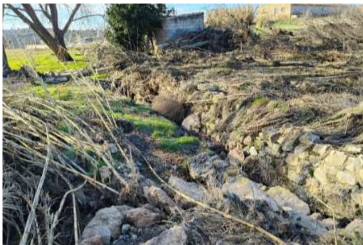
Imagen 2: Acequia aliviadero de pluviales
