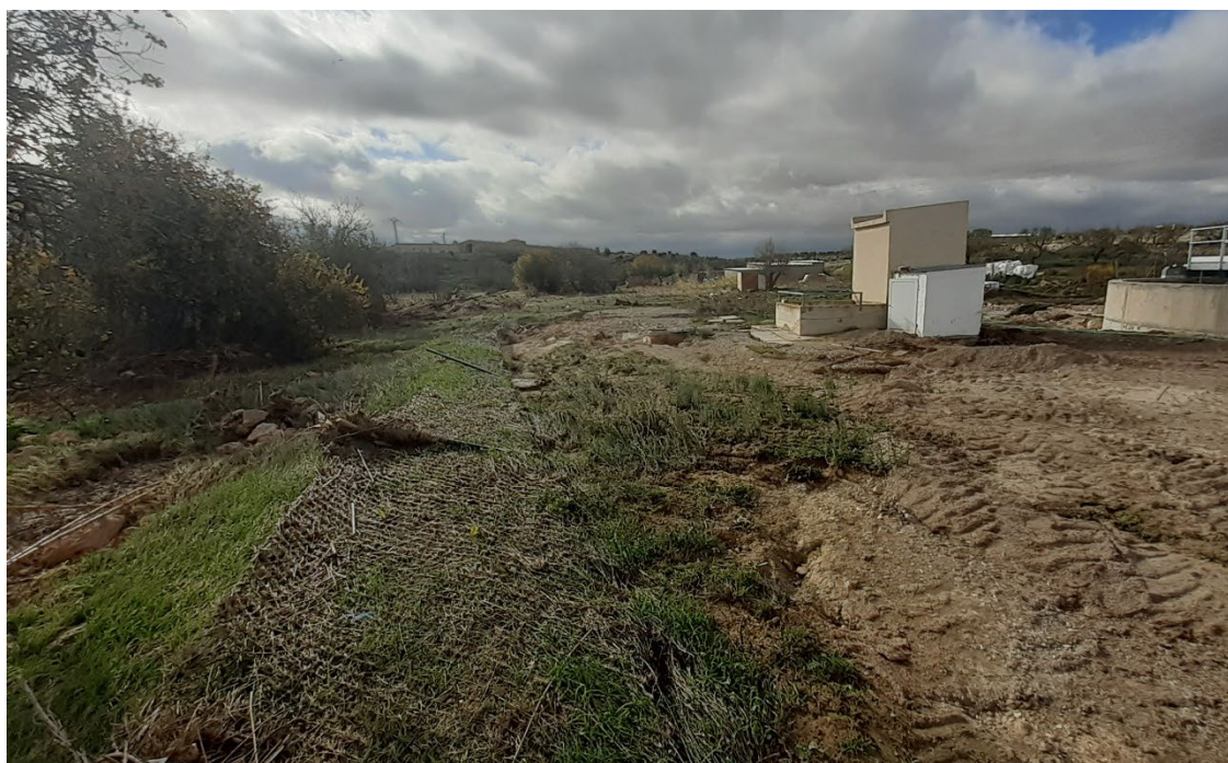
Imagen 9: Cerramiento EDAR Fuenterrobles. Fase 0
