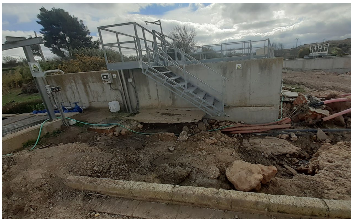
Imagen 7: EDAR Fuenteserres. Fase 0
