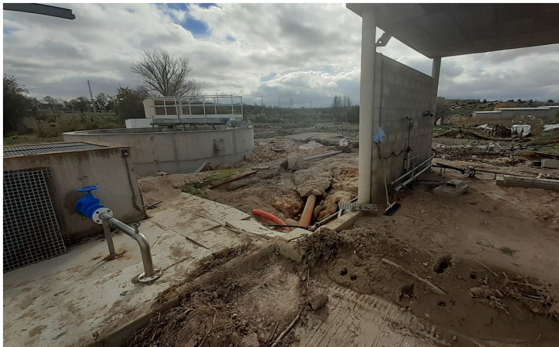
Imagen 6: EDAR Fuenteserres. Fase 0
