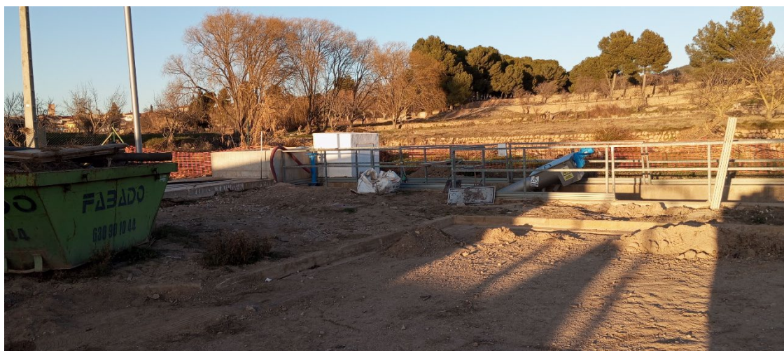
Imagen 2: Urbanización EDAR Fuenterrobles
