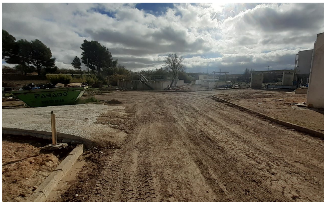
Imagen 5: Urbanización EDAR Fuenterrobles. Fase 0
