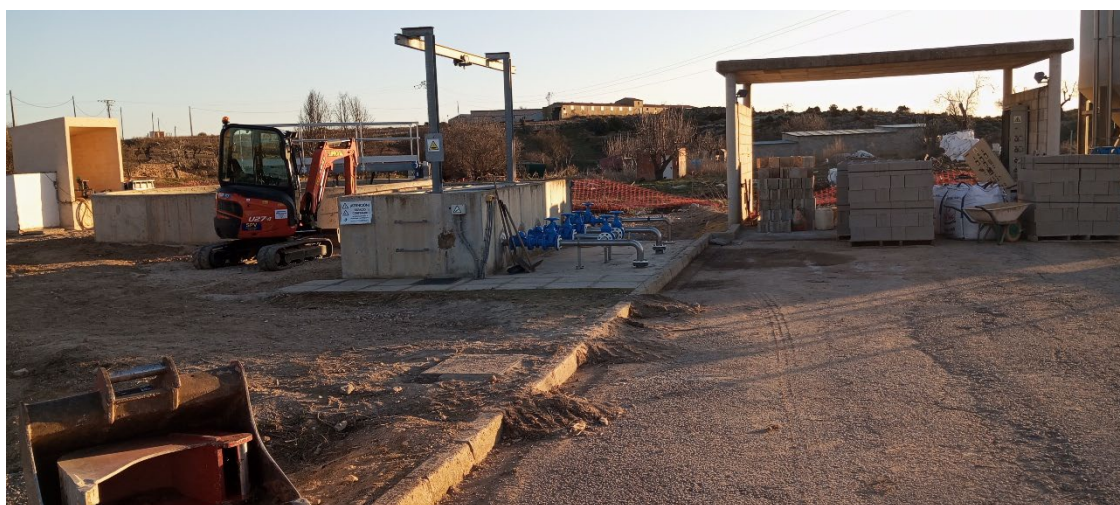
Imagen 3: Urbanización EDAR Fuenterrobles
