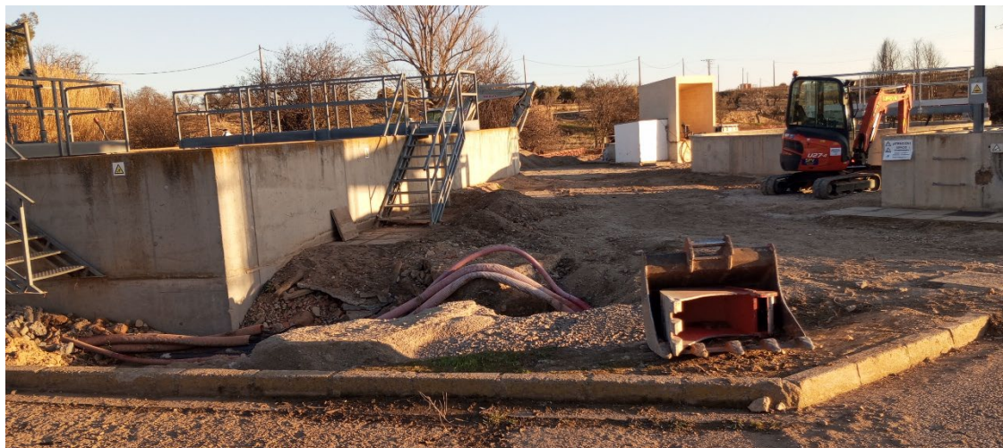
Imagen 1: Urbanización EDAR Fuenterrobles
