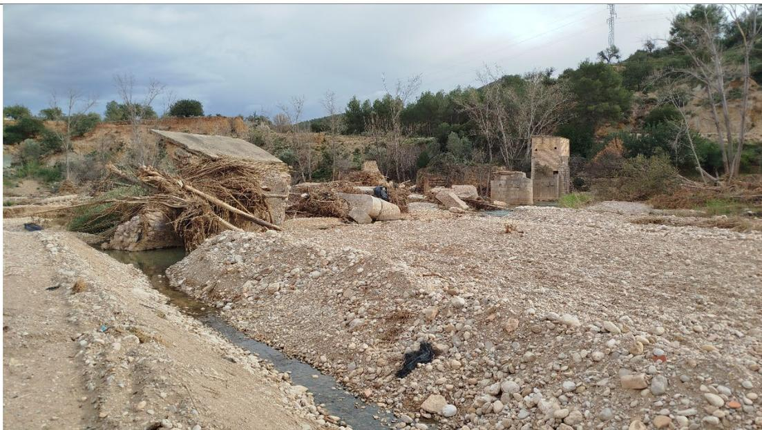
Vista de los restos del "antiguo puente de la riada". La riada provocada por la DANA de 2024 arrastró parte de las pilas que aguantaron las riadas anteriores.
