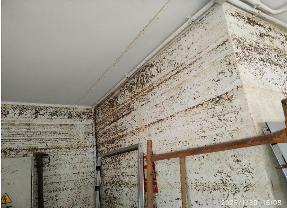
Interior del edificio de la EDAR. Se aprecian restos de barro en paredes y techos.
