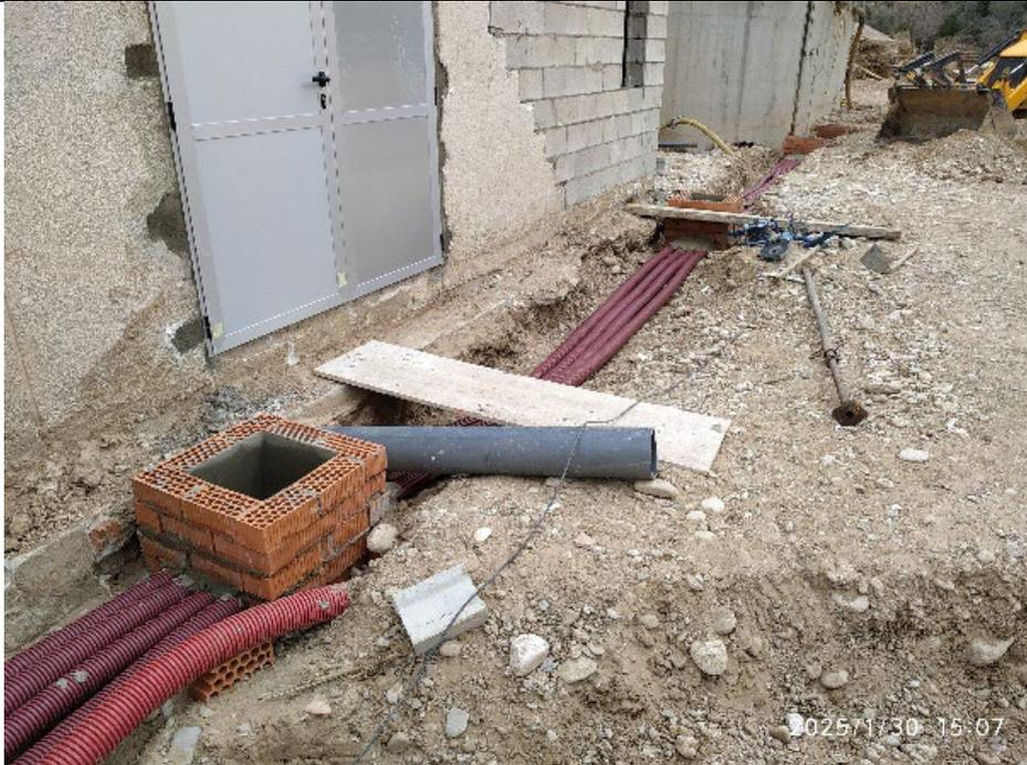
Trabajos de reposición de canalizaciones de electricidad y control.
