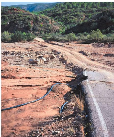
Camino de los chorros (antigua traza). Se aprecia la tubería de abastecimiento y el pavimento arrancado de su lugar.
