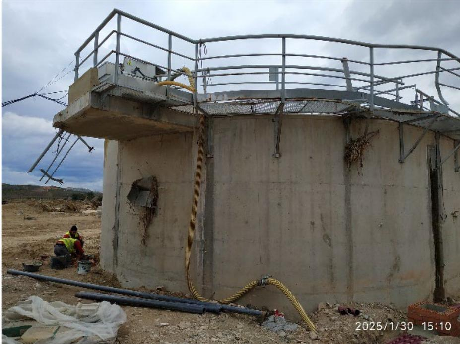
Vistas del reactor biológico, se observan las tuberías provisionales colocadas para el trasiego del agua
