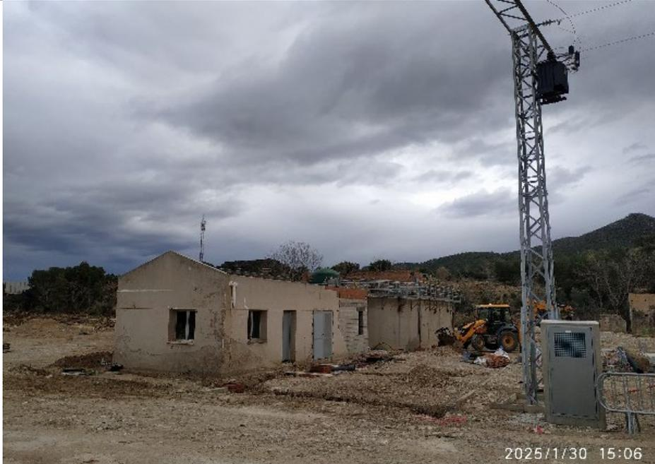
Vista general de las instalaciones de la EDAR de Gestalgar, en reconstrucción. El día de la DANA el agua superó la altura de los edificios e instalaciones, por lo que la planta quedó totalmente inundada
