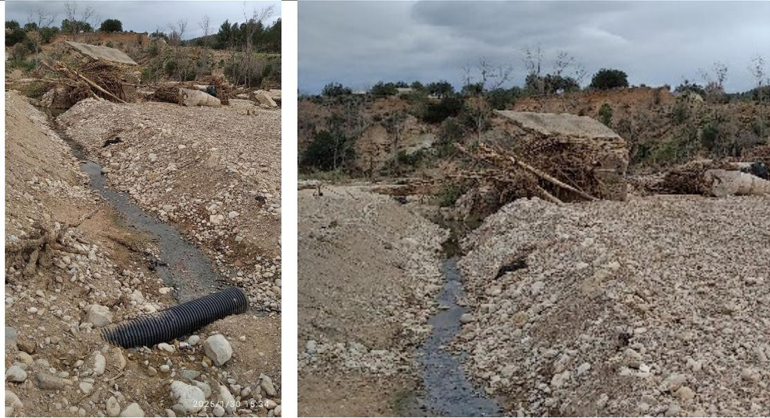
Nuevo punto de vertido de la EDAR, se conduce hacia el cauce reestablecido mediante zanja abierta en los rellenos
