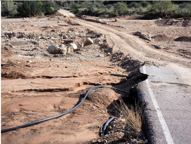
Camino de los chorros (antigua traza). Se aprecia la tubería de abastecimiento y el pavimento arrancado de su lugar.
