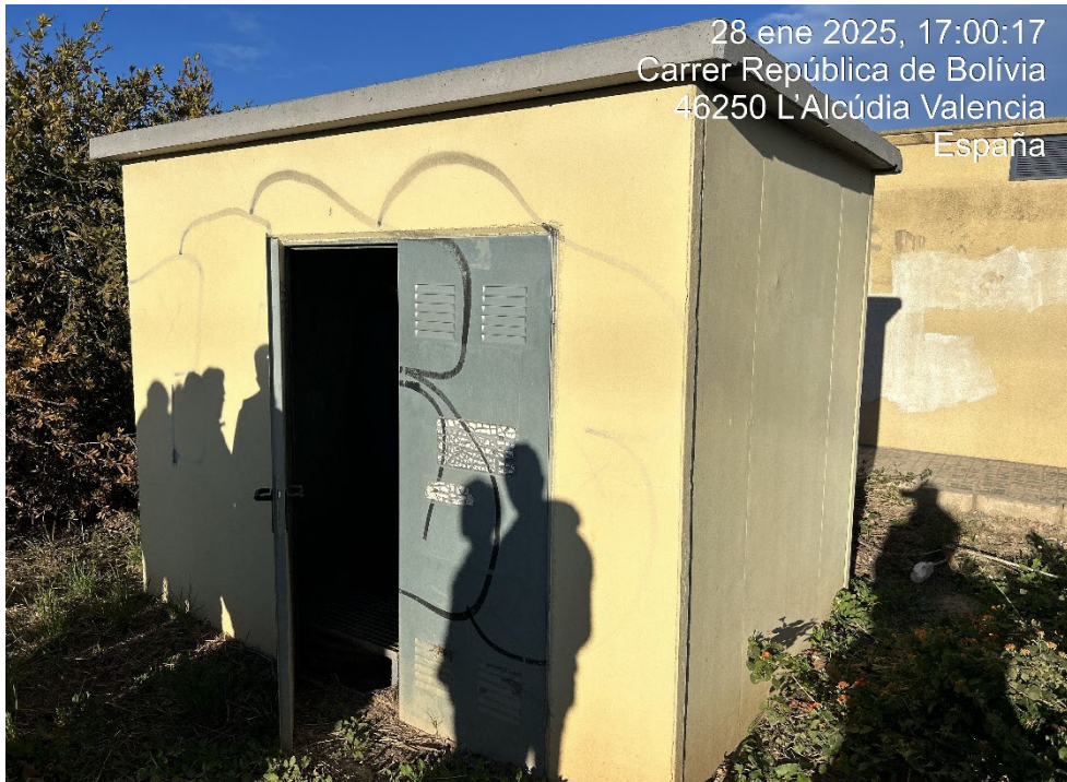
Vista exterior de la EBAR Argentina
