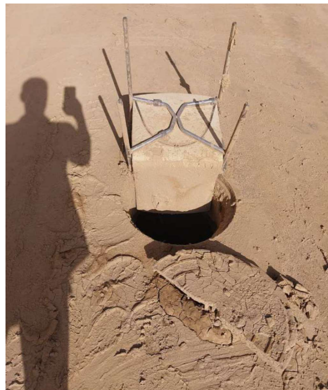
Ilustración 2. Ejemplo de pozo de registro con tapa rota en L'Alcúdia.
