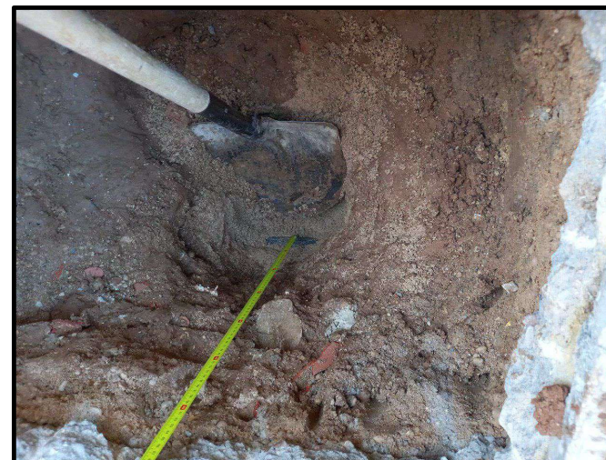
Fotografía nº 2. Reparación de la fuga en la red.
