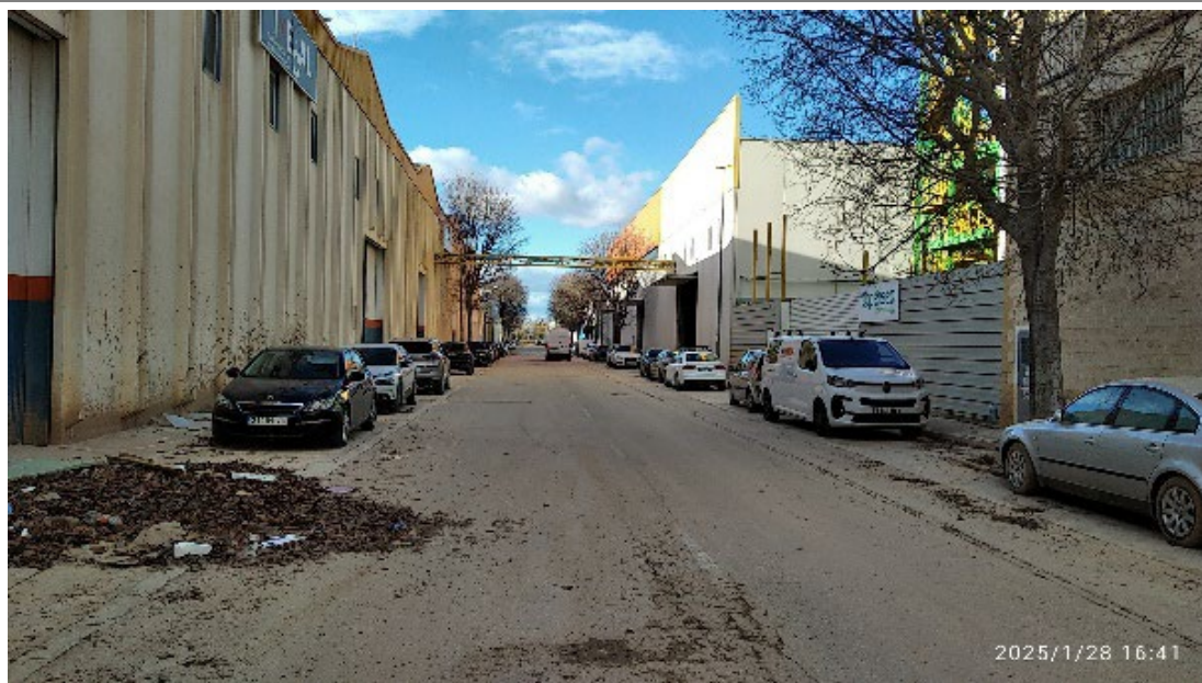
Imagen de la calle Francisco Tomás y Valiente, con colectores afectados por la inundación
