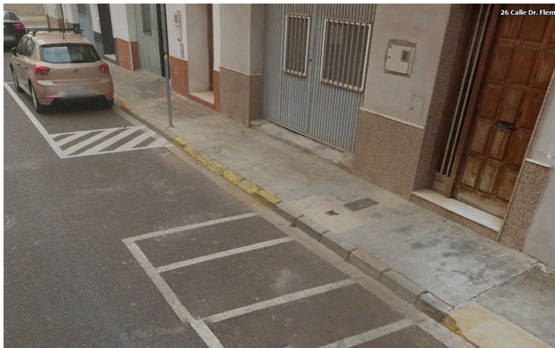
Calle del Dr. Fleming en L'Alcúdia, se observa una acometida de abastecimiento
