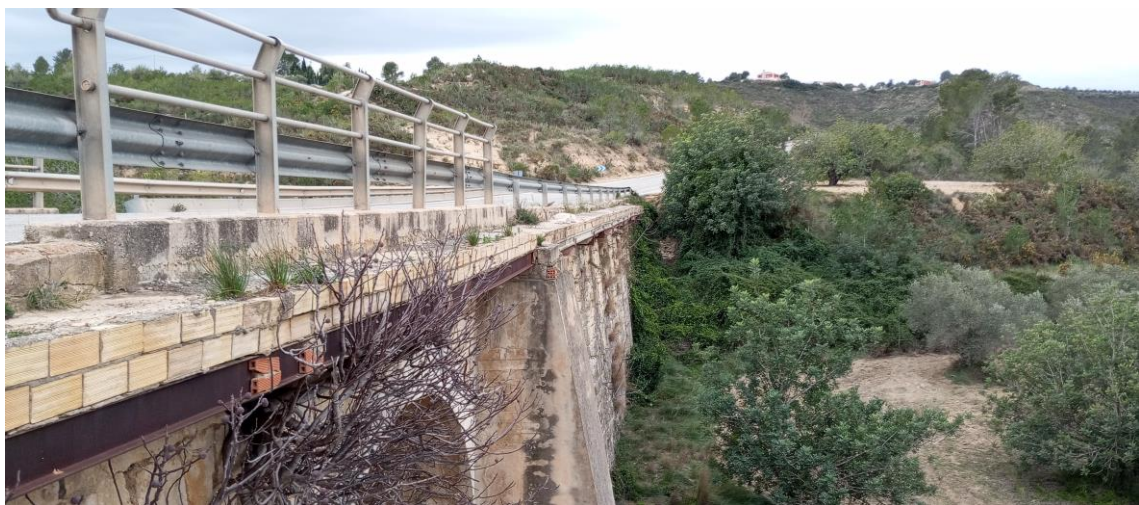
Imagen 3: Cruce barranco tubería FC 250 mm
