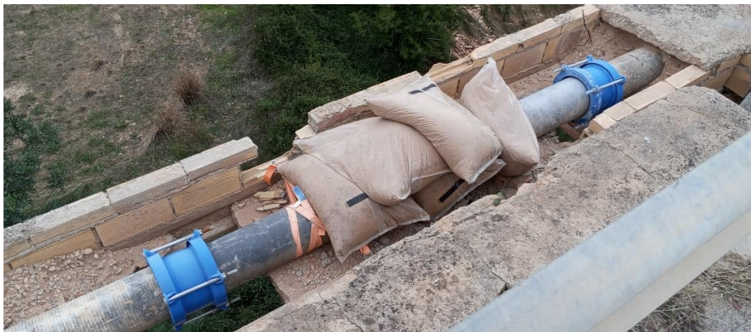
Imagen 1: Cruce barranco tubería FC 250 mm
