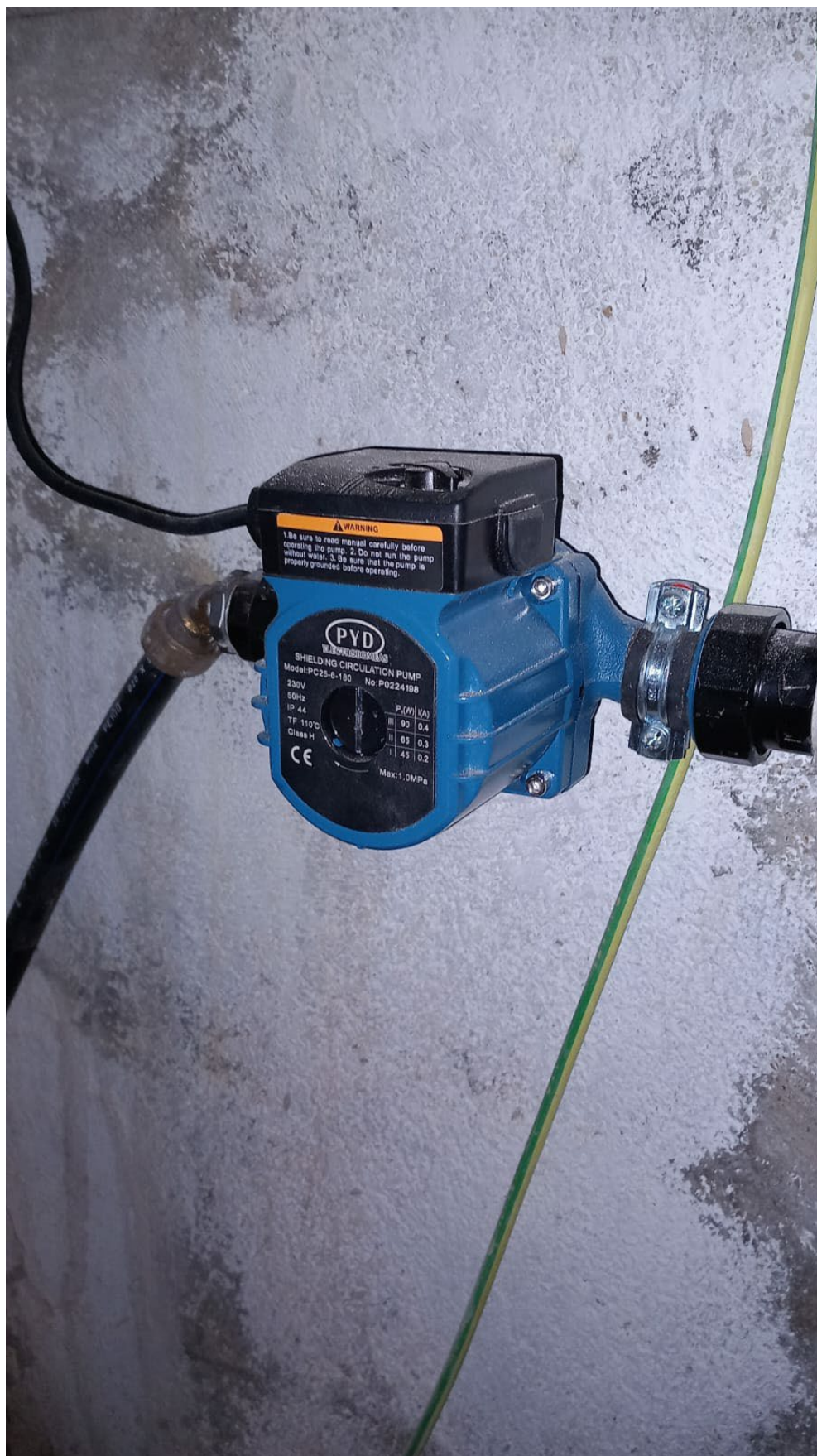
BOMBA RECIRCULACION ANALIZADOR NUEVO
