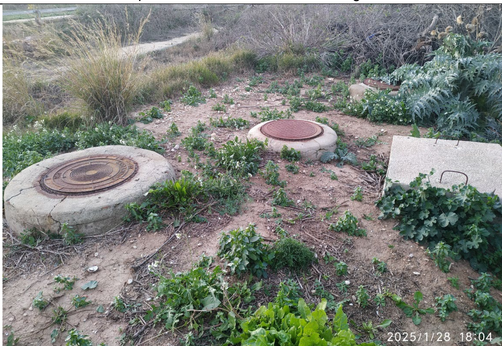
Pozos correspondientes a los colectores de llegada a la EDAR
