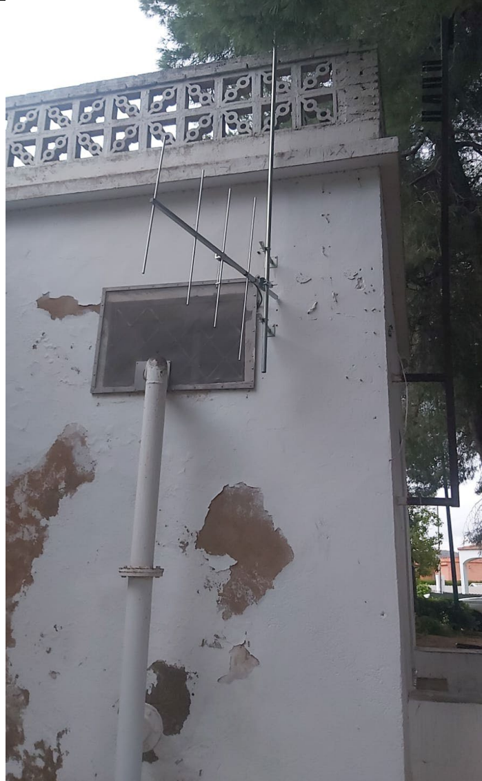
Nueva antena colocada en el depósito de Lloma Paga
