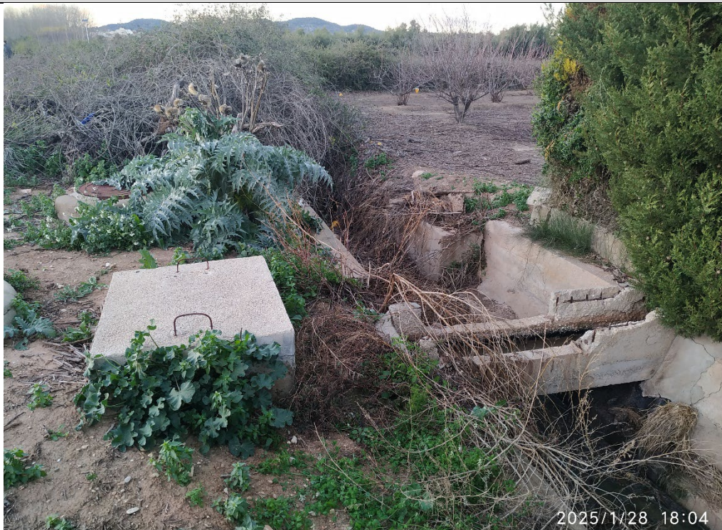
Pozos correspondientes a los colectores de llegada a la EDAR
