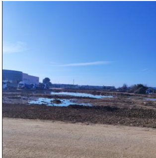
Habilitación de campos intermedias para retirada de lodos
