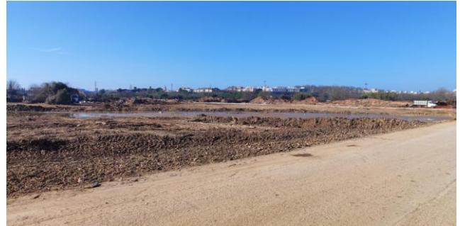
Habilitación de campos intermedias para retirada de lodos
