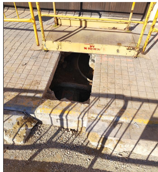
Obras de emergencia para canalización de agua potable y saneamiento en Calle Joan Peset Aleixandre
