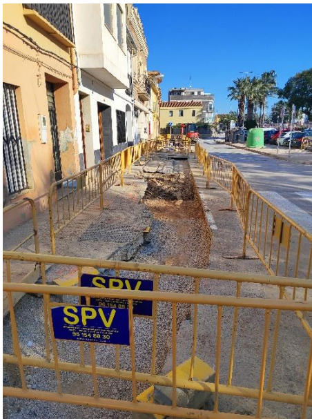
Obras de emergencia para canalización de agua potable y saneamiento en Calle Joan Peset Aleixandre
