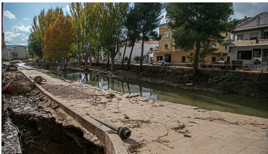
Imagen 2: Paseo peatonal Calle Cercados Fase 0
