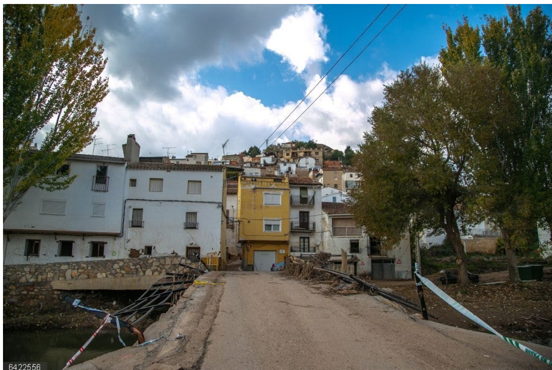
Imagen 1: Puente sobre el río Ojos de Moya
