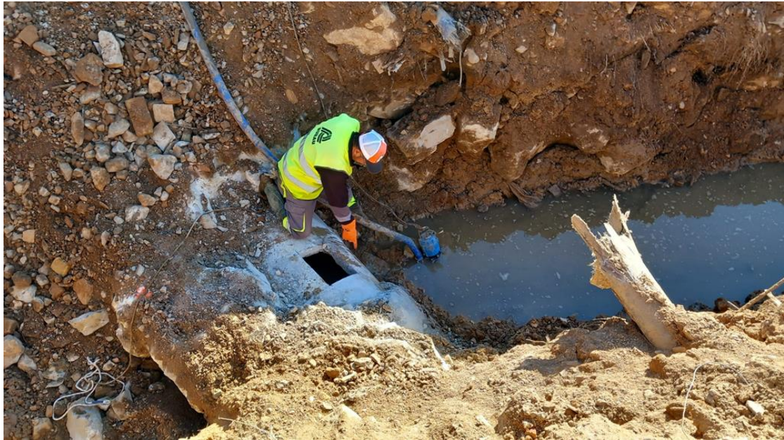
Imagen 1: Actuaciones Fase 0. Vertido 0 a Barranco del Poyo
