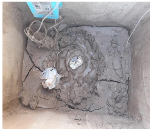
Imagen 20: Estado actual arquetas para alojamiento de instrumentación. Sectorización. Fase 1
