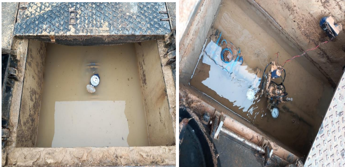
Imagen 21: Estado actual arquetas para alojamiento de instrumentación. Sectorización. Fase 1
