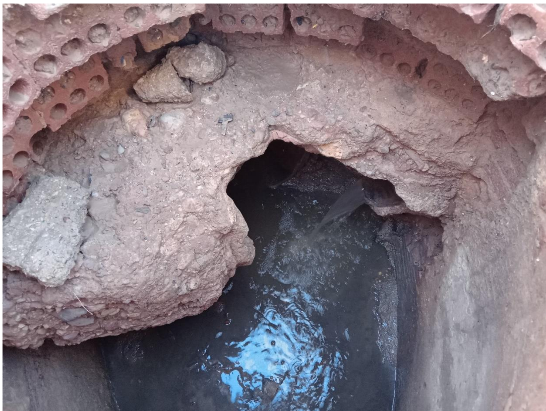
Imagen 12: Actuaciones Fase 0. Red de Saneamiento Casco Urbano. Calle Luis Vives
