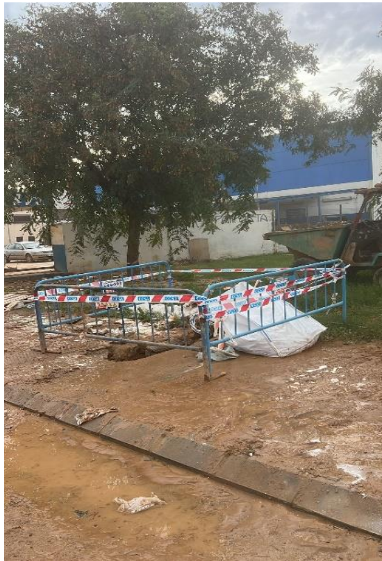
Imagen 19: Actuaciones de renovación de red en P.I. La Pascualeta. Fase 1
