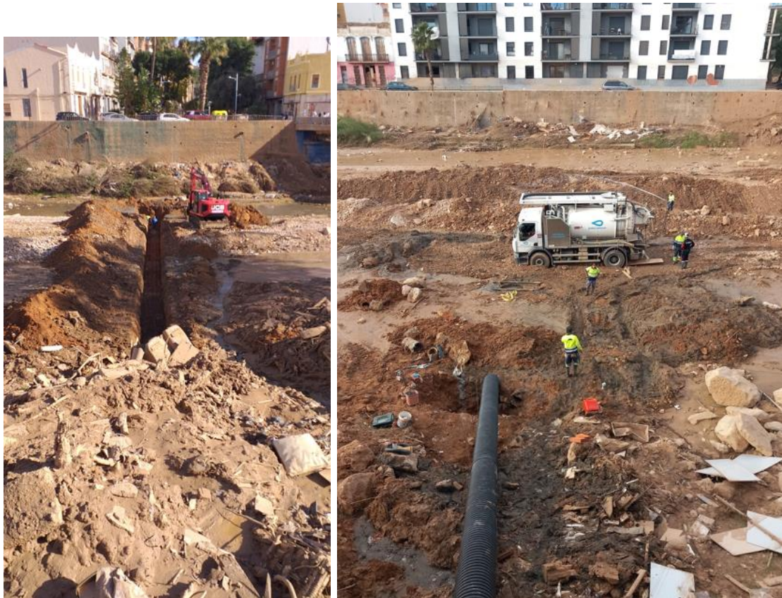
Imagen 9: Actuaciones Fase 0. Vertido 0 a Barranco del Poyo. Calle 9 de Octubre/ Salvador Giner
