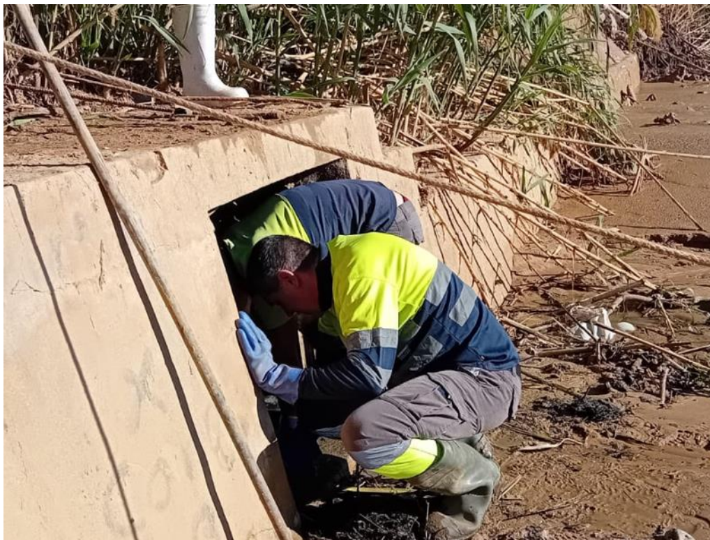
Imagen 6: Actuaciones Fase 0. Vertido 0 a Barranco del Poyo. Calle Torrente
