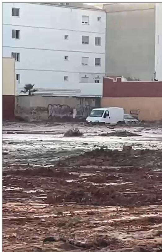
Imagen 16: Fuga en superficie de la tubería de polietileno DN200 afectada
