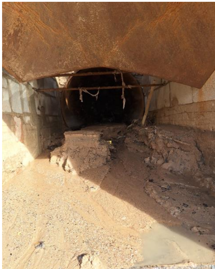
Imagen 7: Actuaciones Fase 0. Vertido 0 a Barranco del Poyo. Calle Torrente
