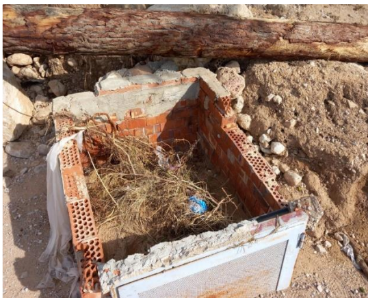
Imagen 20: Estado actual arquetas para alojamiento de instrumentación. Sectorización. Fase 1
