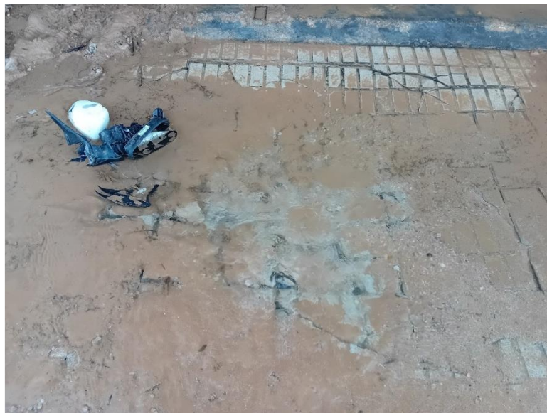
Imagen 17: Actuaciones de renovación de red en P.I. La Estación. Fase 1
