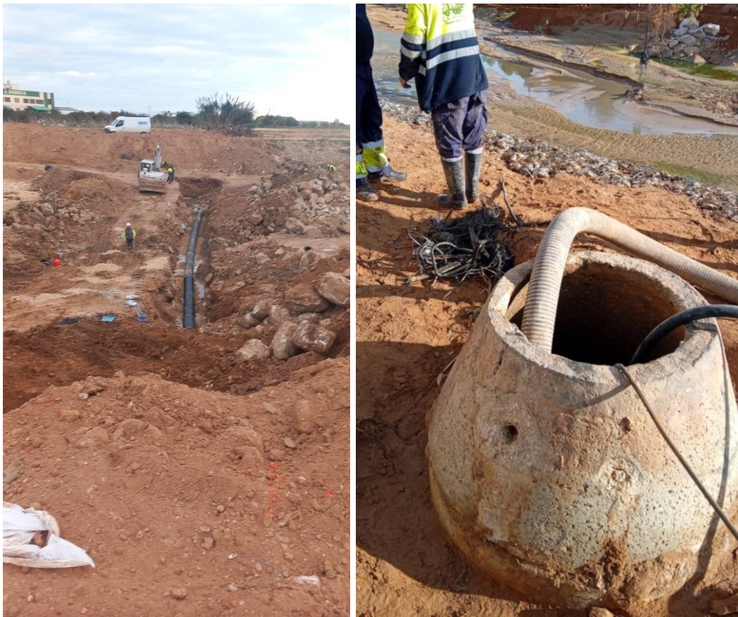
Imagen 2: Actuaciones Fase 0. Vertido 0 a Barranco del Poyo
