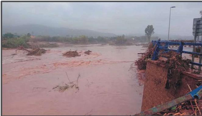
Fotografía nº 2. Estado del puente del cual colgaba la tubería original (2)
