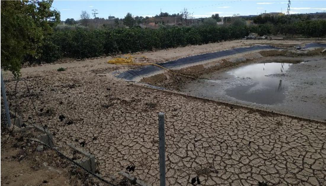
Balsa de afino de la planta, que se está utilizando para almacenamiento y secado de los fangos generados desde la DANA.
