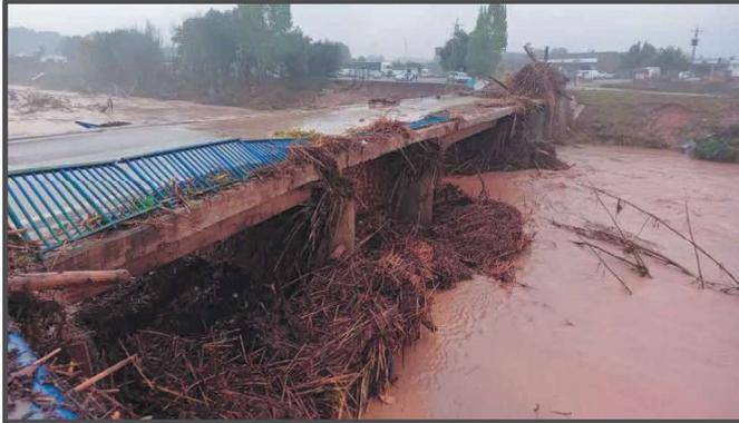
Fotografía nº 1. Estado del puente del cual colgaba la tubería original (1)
