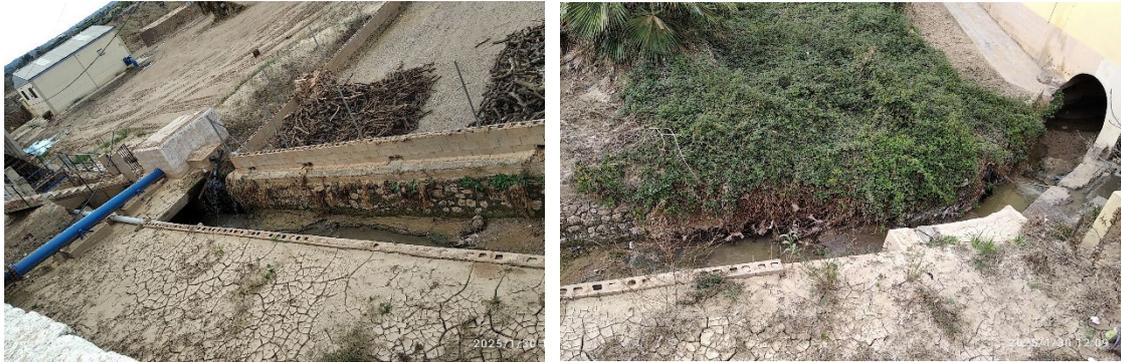
En el cauce del río Turia se aprecian los daños causados por la crecida del río durante la DANA (ver fotografía incluida a continuación). El elevado caudal provocó un aumento de la sección hidráulica, que creció varios metros en altura y se ensanchó varios cientos de metros, e inundó parte del núcleo urbano y toda la vega del río.
