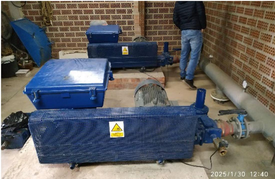
Sala de soplantes del biológico. No se aprecian restos de barro ni daños aparentes en los equipos. Se observan equipos nuevos embalados, en espera de instalación.
