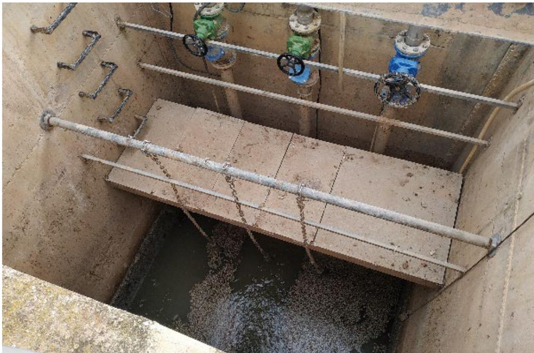
Vista del interior de la cámara de aspiración. Se observan las conducciones de impulsión y las cadenas para extracción de las bombas. Se observa una elevada concentración de sólidos en el agua.
