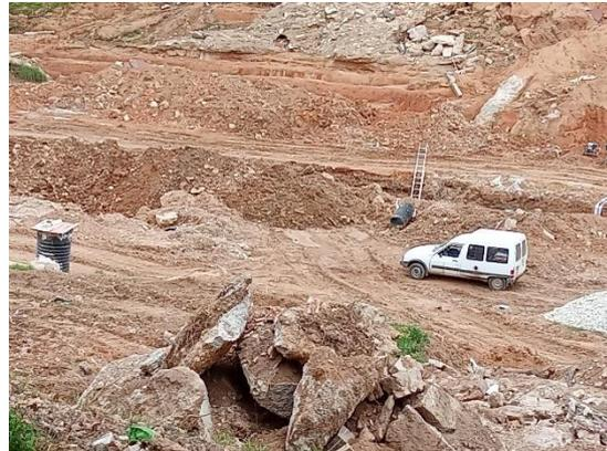
5, 6, 7 y 8. Entronque de colectores de aguas residuales al colector principal existente de hormigón. El nuevo colector principal está en ejecución por EPSAR. Todos los entronques están hechos ya menos uno. Posteriormente se tendrán que ejecutar los entronques definitivos al nuevo colector principal, ejecutado con tubería de PVC helicoidal con refuerzo metálico.
