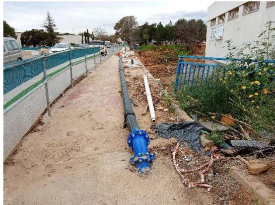
20, 21 y 22. Reparación provisional de agua potable en el puente paseo de Primavera con tubería de PE de 160 mm de diámetro. Antes de llegar al puente, esta tubería se ha colocado enterrada y definitiva de FD de 150 mm de diámetro, al otro lado del puente se ha procedido igual. Se tuvo que poner una bomba al principio para que la red tuviera presión.
