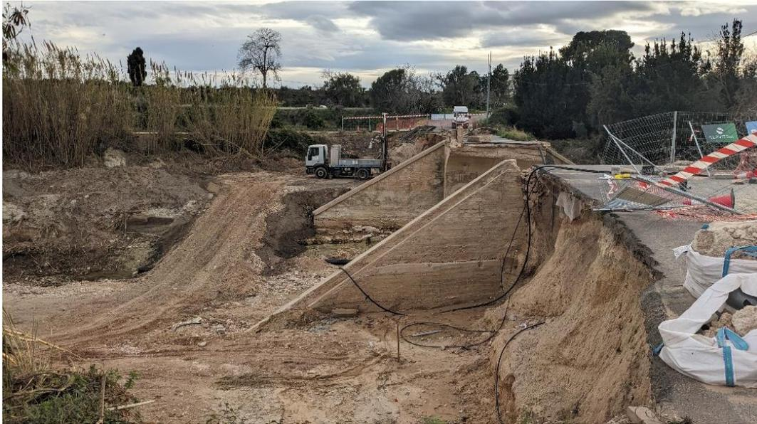
En torno a los restos del puente se identifican varias instalaciones provisionales, como un badén para paso de vehículos, una conducción provisional de abastecimiento para restituir el servicio de la que iba colgada del puente desaparecido o tramos de tubería para derivación el caudal de aguas bajas del barranco.
