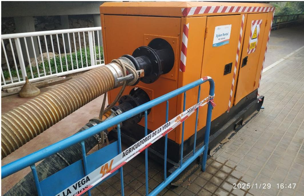
Bombeo compacto de baipás instalado tras la DANA para el cruce del barranco aguas abajo del puente de la autovía.
