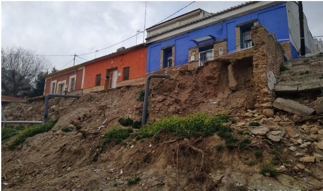
Estado actual de las viviendas en la margen izquierda del barranco, aguas arriba del puente de L'Omet, se precian las conducciones de saneamiento en precario.
