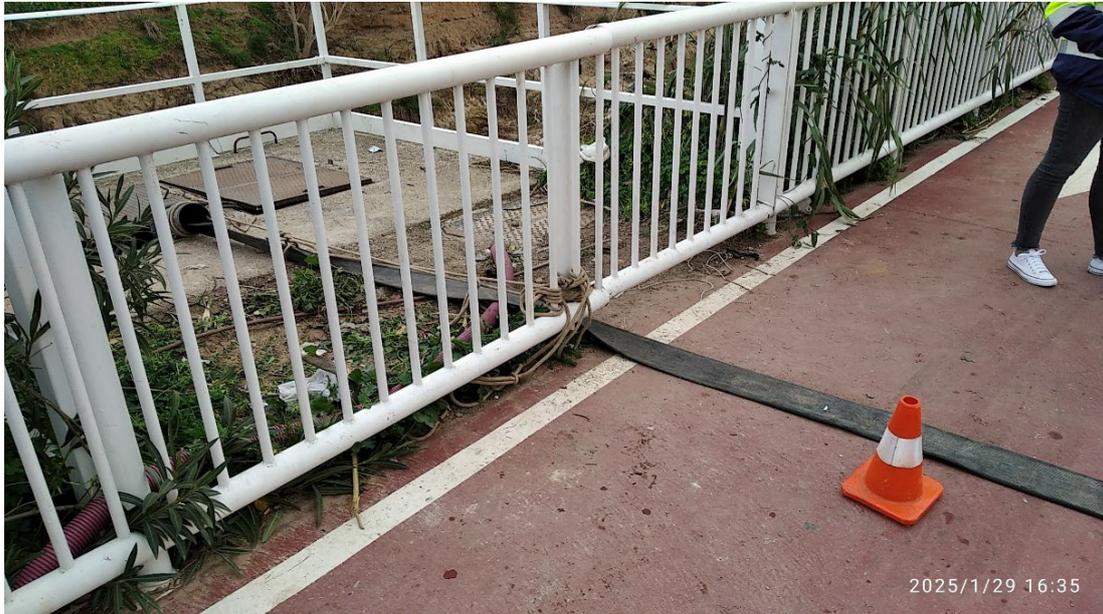
EBAR Barranco: vistas de la conducción del bombeo provisional instalado tras la DANA.
