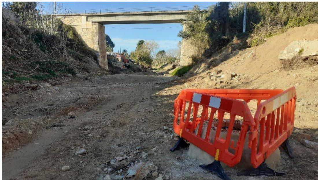
Estado actual de barranco de Picassent aguas abajo del puente de L'Omet, en primer plano se observa un pozo de saneamiento afectado.
