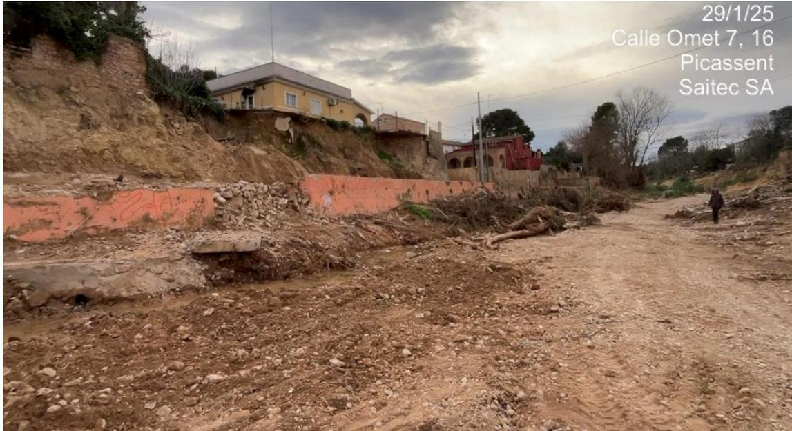
Y en la margen izquierda se observa una elevada erosión del talud, que se ha quedado a las puertas de las viviendas existentes, que se encuentran clausuradas por cintas de la policía. En la fotografía siguiente se observan los conductos de recogida de aguas de las viviendas, en estado precario.
