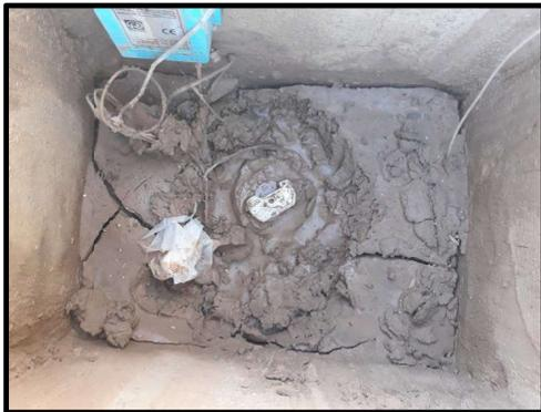
*Fotografía 2. Estado actual arquetas de sectorización afectadas. Detalle 2.*
