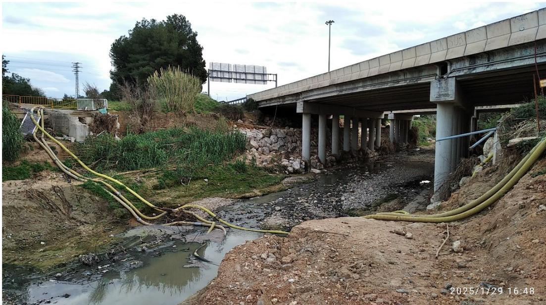
Conducciones de impulsión provisionales para el cruce del barranco aguas abajo del puente de la autovía. Se observan también los restos del estribo de margen derecha de la pasarela peatonal que fue destrozada por la crecida.
