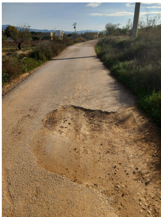
Imagen 6: Acceso a la EDAR
