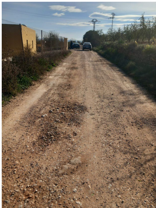
Imagen 5: Acceso a la EDAR
