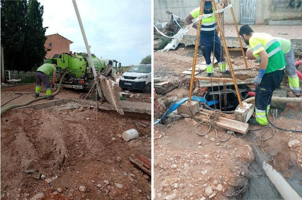
Este mismo día, se realizó la instalación de una bomba de achique provisional, suministrada por la empresa externa, que desvía el agua hacia el barranco como medida temporal, a la espera de la renovación del sistema de bombeo. A continuación, se muestran en las fotografías de la instalación de la bomba provisional.
