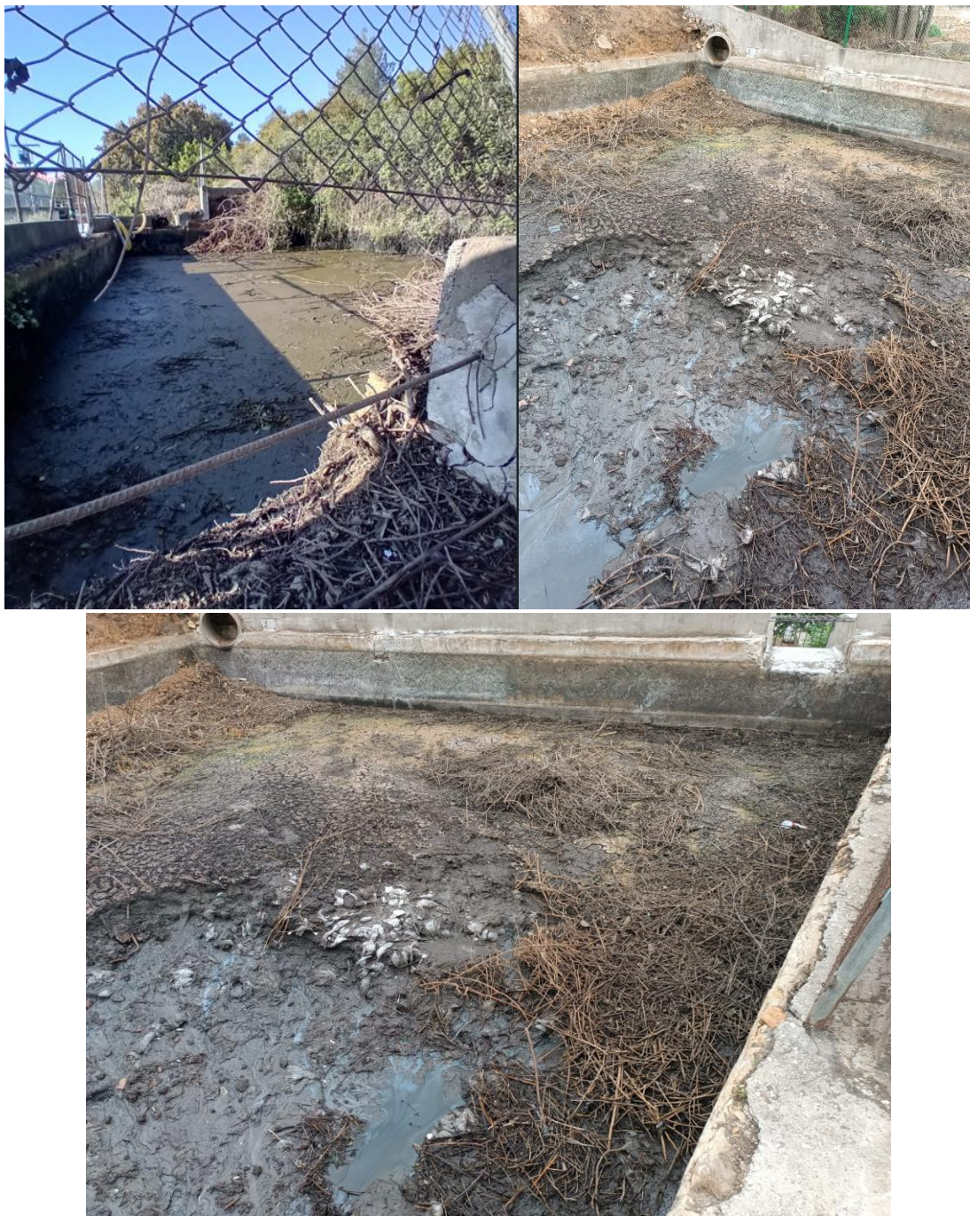
Estado de la balsa de riego. Fuente: EGEVASA.
