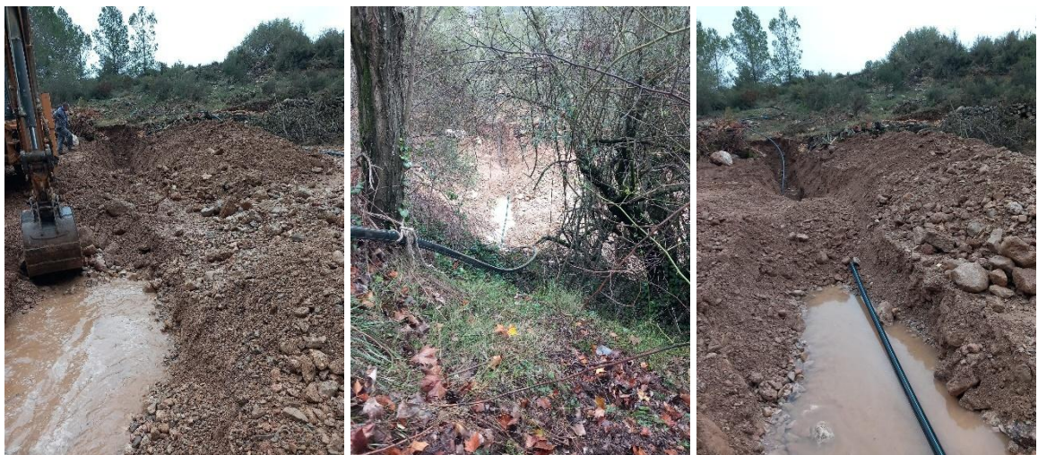
Adecuación del barranco y colocación de la tubería. Fuente: Global Omnium.
