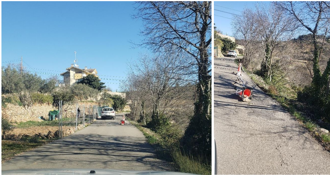
Afecciones en el camino de acceso a la EDAR. Fuente: Visita realizada (06-02-2025).
