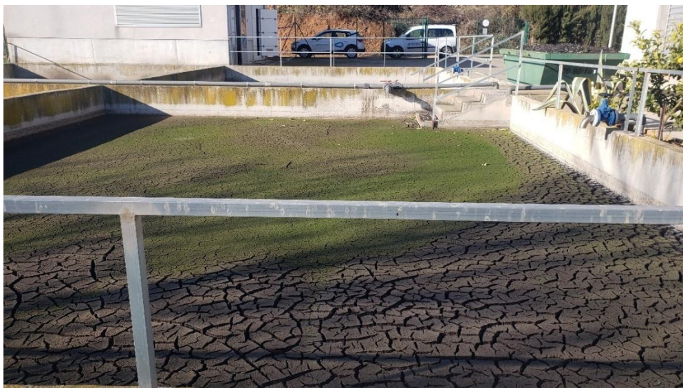
Eras de secado de la EDAR de Siete Aguas. Fuente: Visita realizada (06-02-2025).
