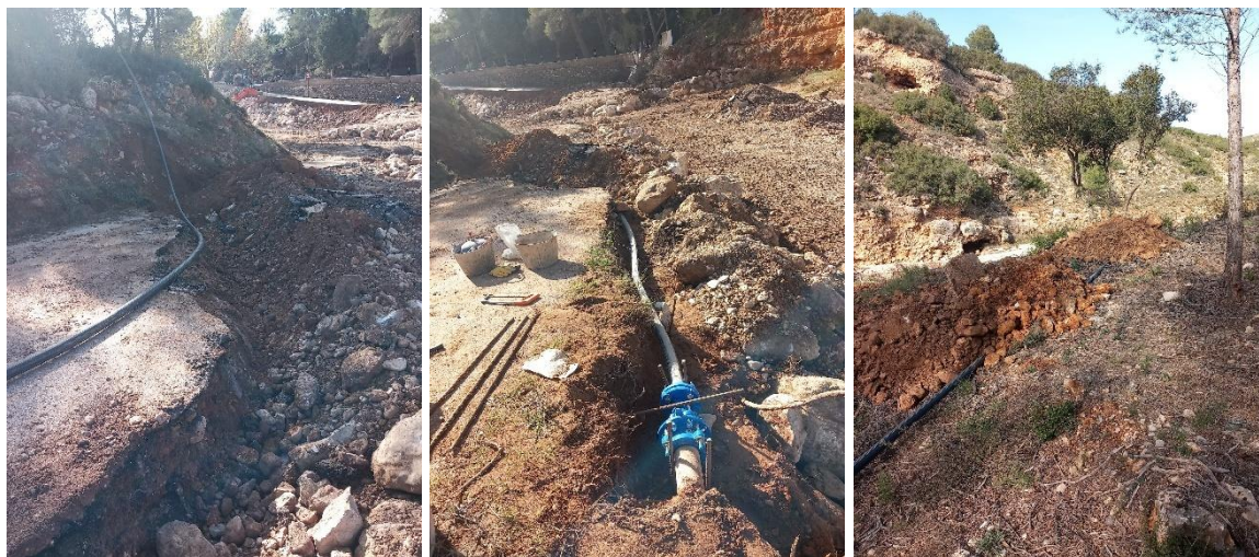
Colocación de la tubería sin zanja. Fuente: Global Omnium.
