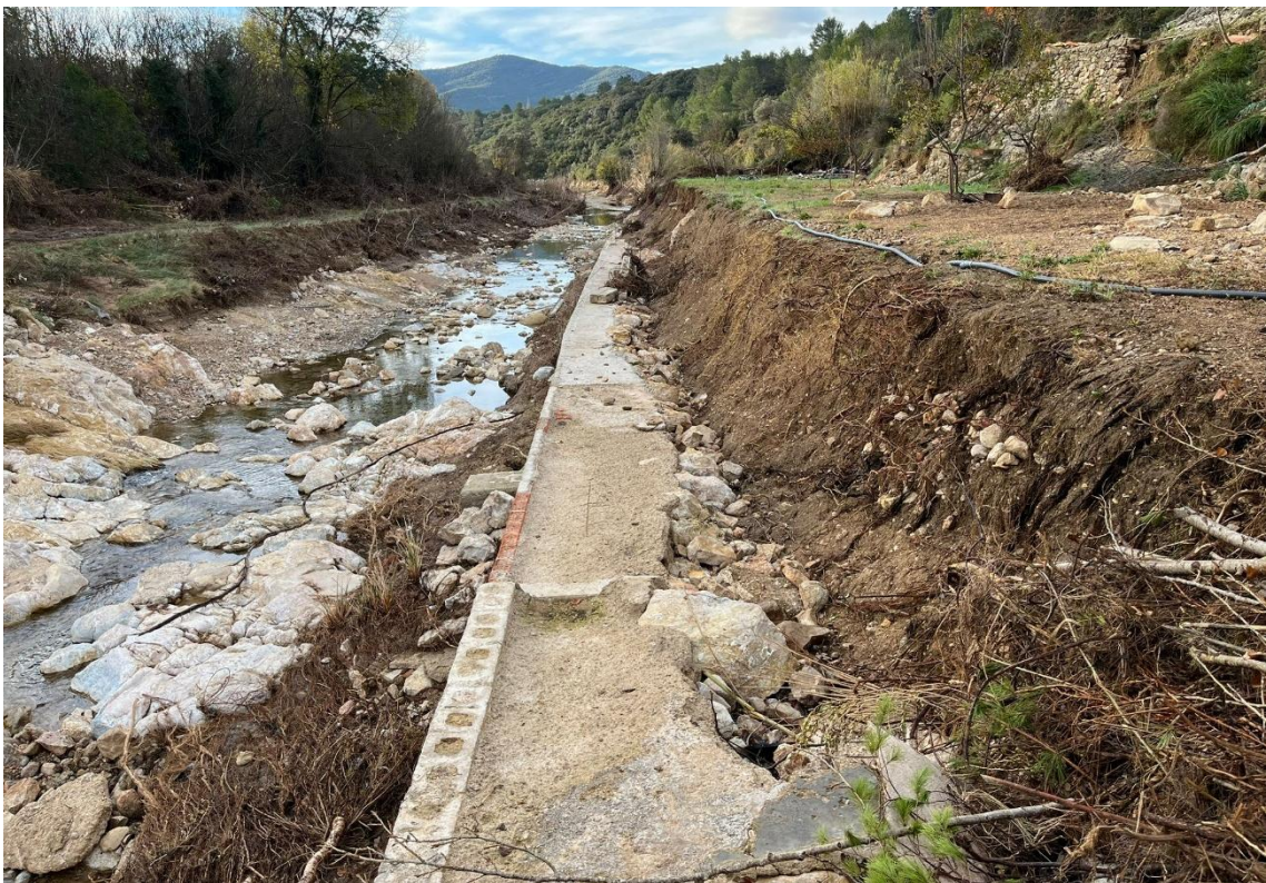
Punto de vertido al cauce. Fuente: EGEVASA.
