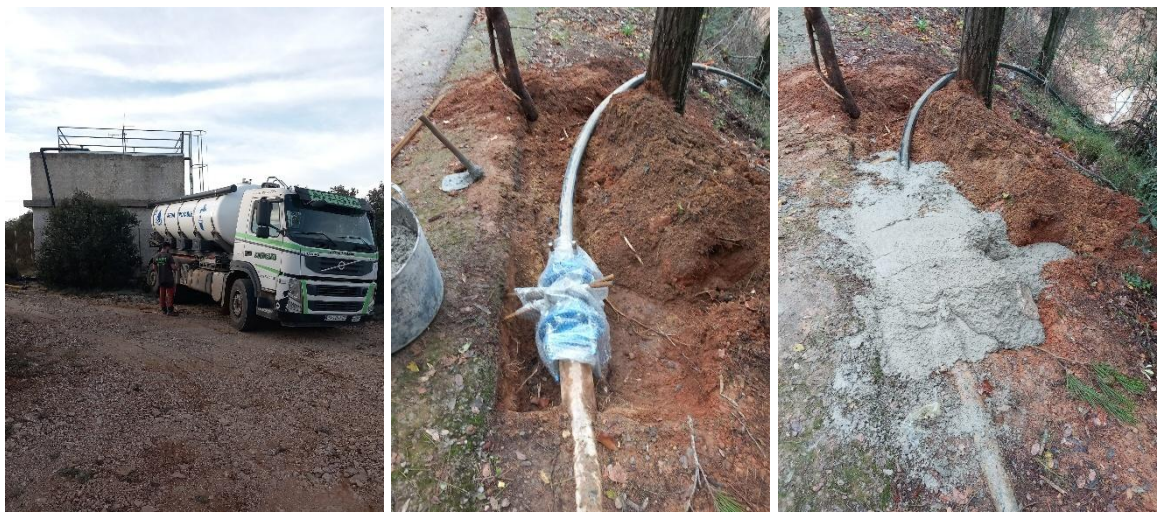
Llenado del depósito de La Lloma y conexión a la red en buen estado. Fuente: Global Omnium.
