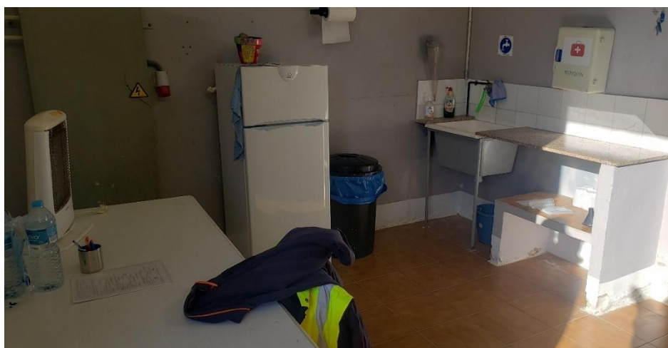
Sala de control de la EDAR de Siete Aguas. Fuente: Visita realizada (06-02-2025).
