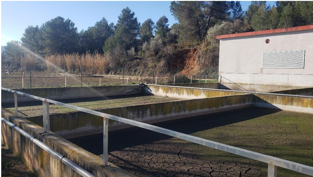
Estado del vallado exterior de la EDAR de Siete Aguas. Fuente: Visita realizada (06-02-2025).
