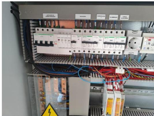
Reposición limitador de sobretensiones PRD Schneider Electric.
