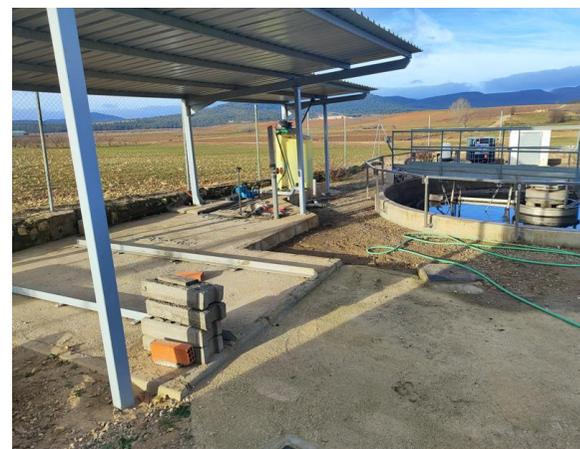
Emplazamiento mesa espesadora y bomba helicoidal de fangos.
