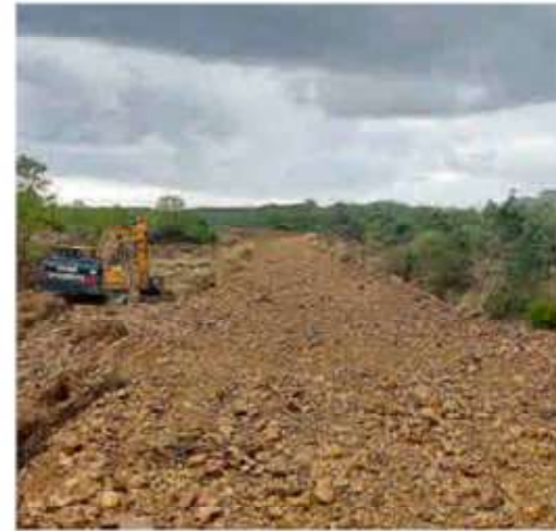
Obra en el malecón de Santa Croya de Tera. | C. G. R.
