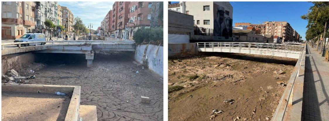
*Figura 85 Ejemplos de pasos existentes (viario y peatonal), en el tramo encauzado*
