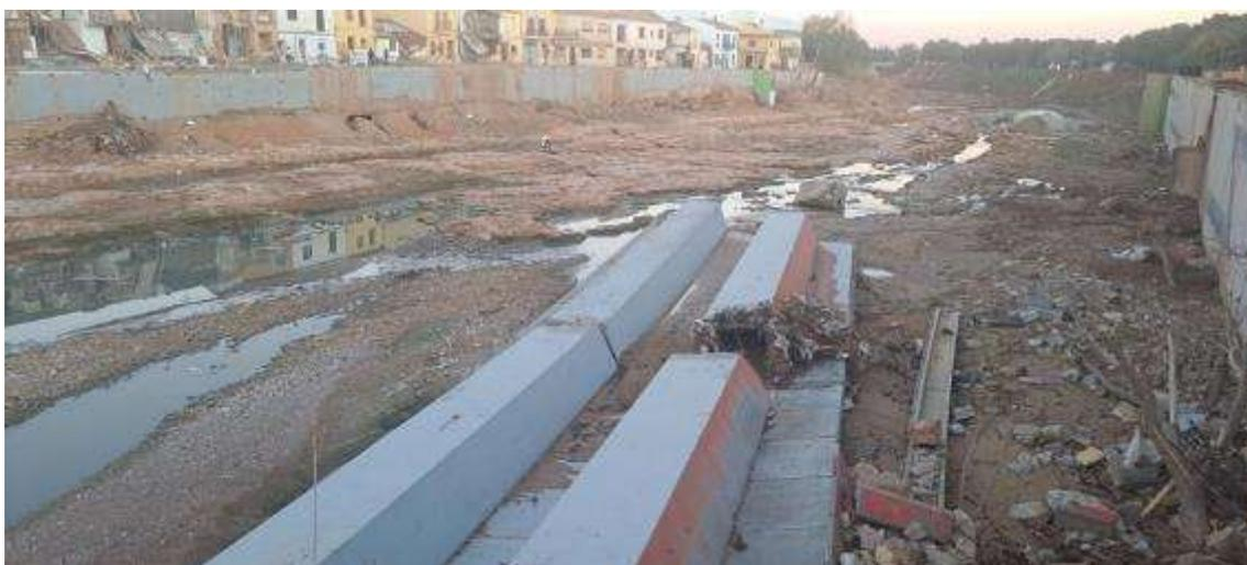
*Figura 41 Estado del Barranco del Poyo en Picanya tras la DANA. Se observa el tablero de la pasarela peatonal destruida sobre el cauce y la destrucción generalizada de gran parte de las viviendas existentes.*
