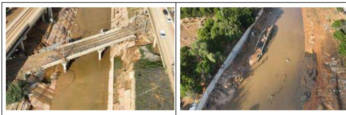
*Figura 43 Estado de los tramos encauzados del barranco del Poyo tras la DANA en su tramo medio-bajo*
