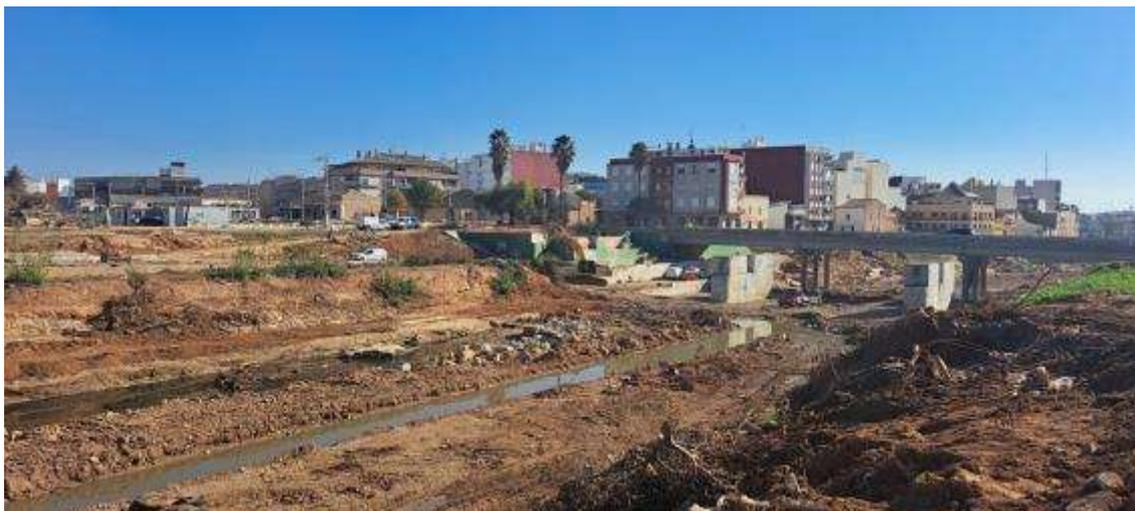
*Figura 42 Estado del Barranco del Poyo en la entrada a Paiporta tras la DANA. Además de la destrucción del puente, se aprecia el notable incremento de la sección del cauce al haber sido destruidas gran parte de las instalaciones que había en las márgenes.*
