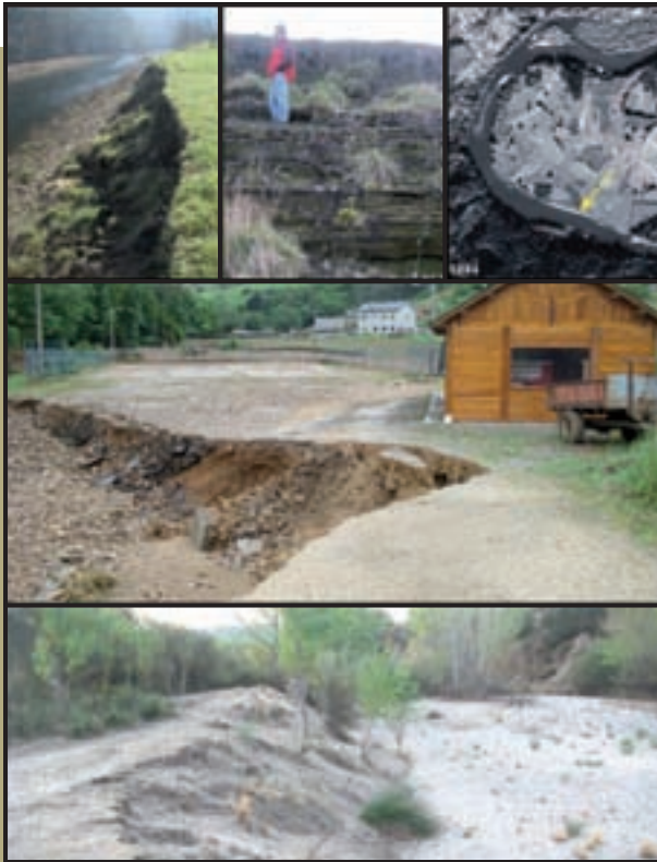
Figura 136. Orillas erosivas con alta pendiente, escasa cubierta vegetal y desprendimientos, observadas en campo y sobre fotografía aérea. Imagen central: TRAGSA.
