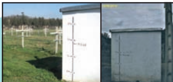
Figura 115. Inscripción con el alcance de la avenida de febrero de 2007 (1,40 m). Nueva marca para la avenida del 12 de junio de 2010 y marca en el pilar eléctrico del 16 del mismo mes (río Nalón en Pravia, Asturias).
