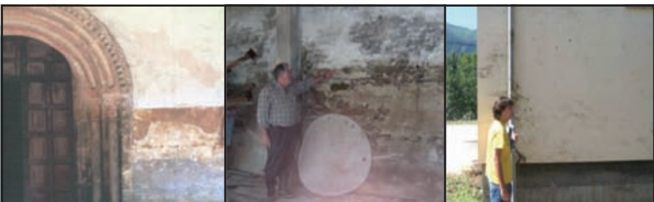
Figura 110. Tintado de fachadas provocado por los sedimentos en suspensión, que aporta valores de alta precisión en el calado alcanzado por las inundaciones (fuente: INDUROT, 2004).
