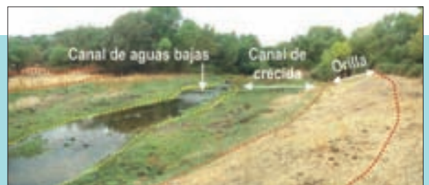
Figura 127. En rojo los escarpes a tener en cuenta en la delimitación del cauce en el río Guadarrama en Villalba, Madrid.
