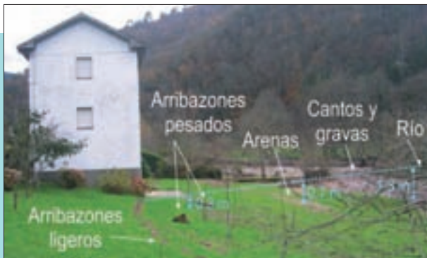
Figura 144. Distribución habitual de evidencias, con depósito de flotantes (arribazones ligeros) en zonas alejadas y sedimentos en las zonas con mayor calado y velocidad. En azul, el calado deducido a partir del nivel de los arribazones ligeros.
