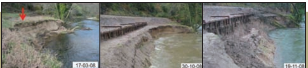
Figura 177. Orilla erosiva altamente inestable, manifestando una movilidad próxima a los 30 m en 8 meses (fuente: TRAGSA).
