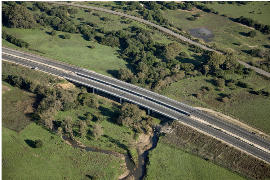
Figura 4.5. En las intersecciones de las vías con los corredores fluviales, la construcción de viaductos permite garantizar la funcionalidad de estos conectores ecológicos. Foto: GIASA, Junta de Andalucía.
