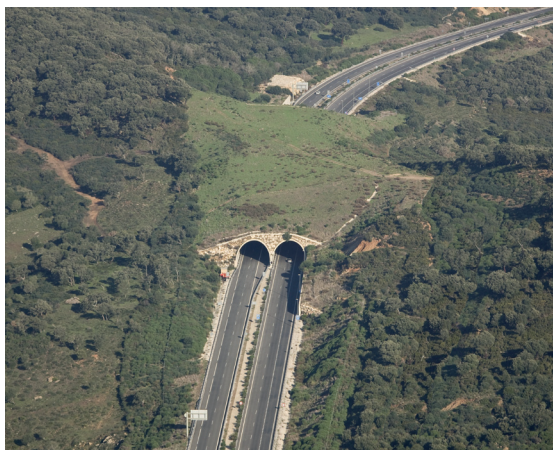
Figura 4.2. Los túneles, falsos túneles restaurados y viaductos permiten la continuidad de hábitats a través de las infraestructuras. Fotos: GIASA, Junta de Andalucía y DG de Calidad Ambiental, Consejería de Medio Ambiente y Ordenación Territorial, Gobierno de Canarias.
