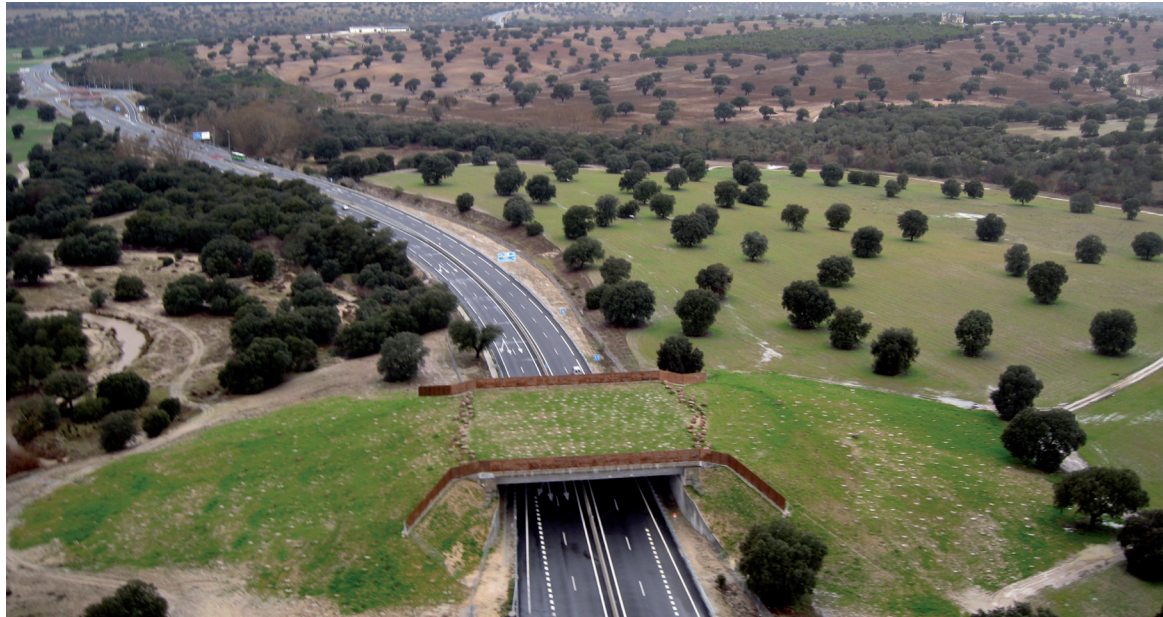
Figura 4.3. La construcción de pasos específicos para la fauna aumenta la permeabilidad de la vía, especialmente cuando cuentan con una restauración adecuada. Foto: DG de Carreteras, Consejería de Infraestructuras y Transportes, Comunidad de Madrid.
