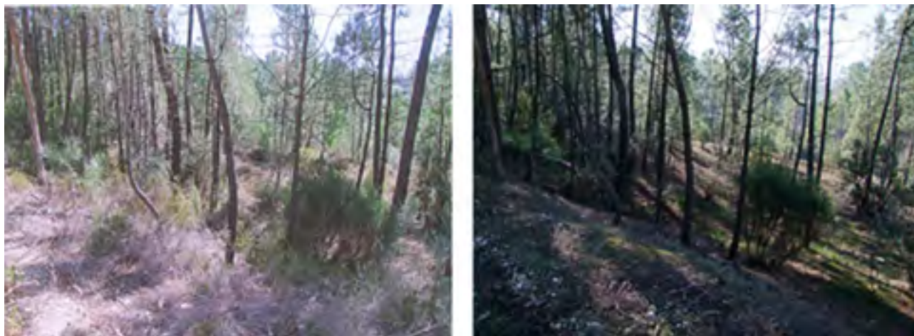
Figura 3. Limpeza de matos motomaniual no Âmbito de um projeto PRODER – Medida de Defesa da Floresta contra Incêndios. Fotografia antes e depois da intervenção.
