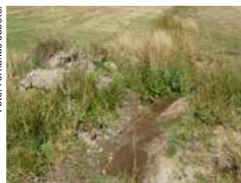
Pequeñas obras de drenaje en una colonia de hormiguera oscura.
