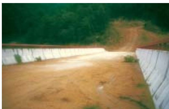
Figura 3.3 – Paso superior con la superficie cubierta de tierras procedentes de los terrenos adyacentes. Foto: R. Campeny.
