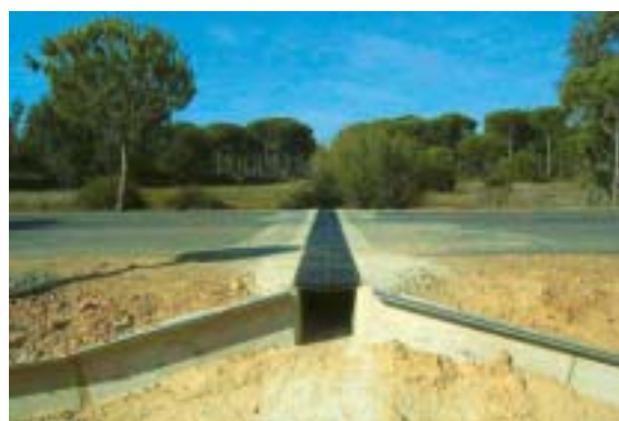
Figura 11.3 – Paso de anfibios con estructura de guía formando embudo. Foto: GIASA.
