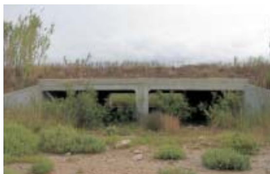
Figura 6.4 – Las revegetaciones facilitan integración del paso en su entorno. Foto: F. Navàs.
