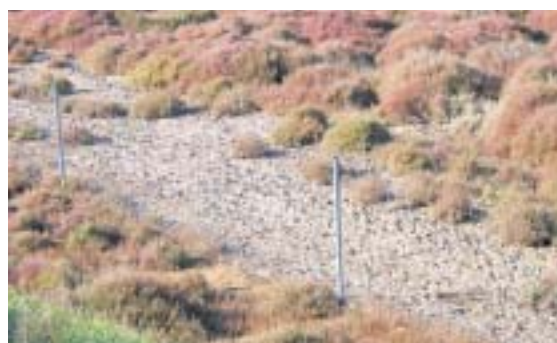
Figura 13.3 – El cerramiento conduce los movimientos de los animales hasta localizar los pasos. Foto: C. Rosell.
