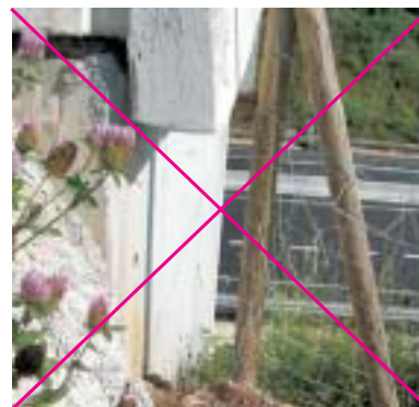
Figura 13.12 – Ajuste deficiente entre la valla y la aleta del paso. Foto: F. Navàs.
