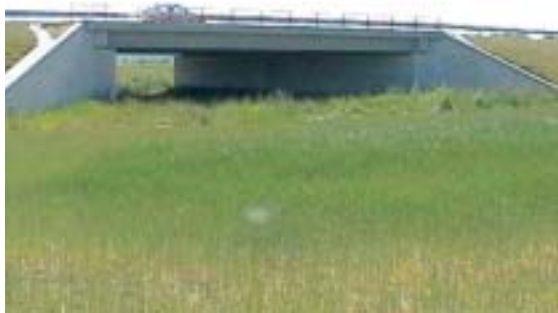
Figura 6.2 – Estructura de dimensiones adecuadas y que muestra un buen acondicionamiento de sus accesos. Foto: J. Dufek.
