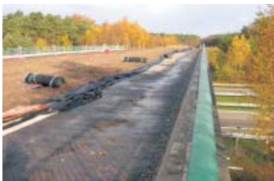
Figura 2.6 – Aislamiento de la base de la estructura y drenaje de su superficie. Foto: C. Rosell.
