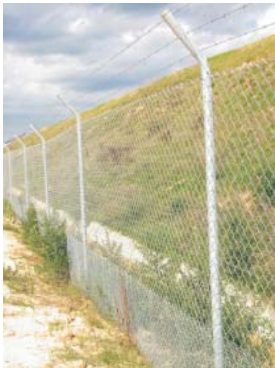
Figura 14.5 – Cerramiento que combina prolongación para impedir el salto de cérvidos y refuerzo basal para pequeños vertebrados. Foto: M. Fernández Bou.
