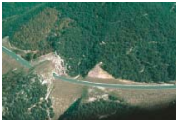
Figura 1.4 – Un falso túnel constituye una oportunidad para establecer un ecoducto, pero debe restaurarse adecuadamente su superficie. Foto: M. Pey.
