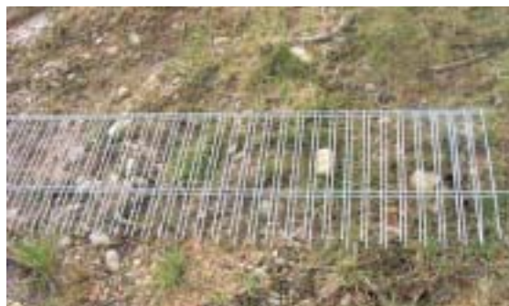
Figura 13.6 – Detalle del refuerzo de malla electrosoldada. Foto: C. Rosell.
