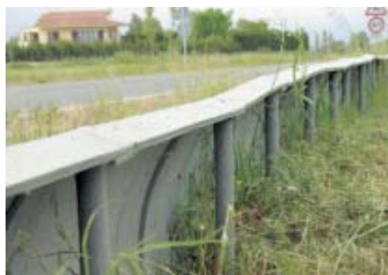
Figura 11.5 – Estos cerramientos prefabricados son de fácil colocación, aunque requieren mantenimiento frecuente y dificultan las tareas de siega. Foto: C. Rosell.
