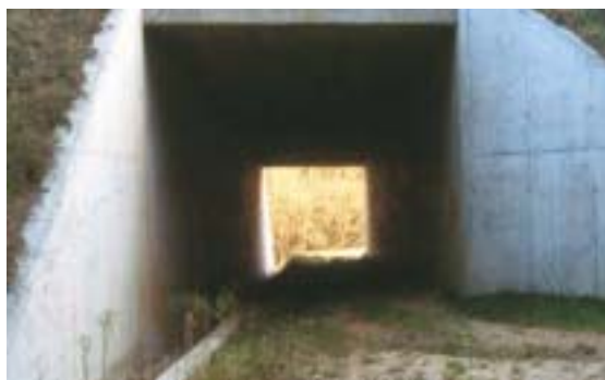
Figura 7.7 – Estructura que combina el paso de fauna con un camino forestal. Por la zanja lateral se canaliza una acequia. Foto: F. Navàs.
