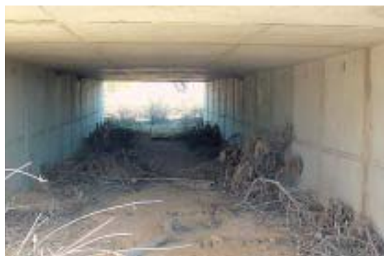
Figura 8.3 – Hileras de ramas secas para facilitar refugio a animales de pequeño tamaño. Foto: P. Robles.
