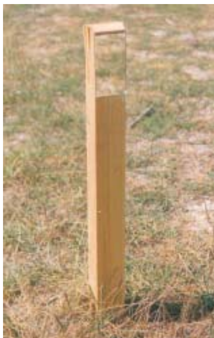
Figura 18.2 – Existen diversos modelos de reflectores utilizados para proyectar las luces de los faros hacia el entorno de la vía. Estos sistemas requieren tareas frecuentes de mantenimiento y su efectividad es temporal. Fotos: C. Rosell, J.M. Velasco.
