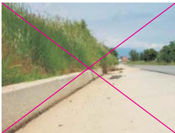
Figura 20.4 – La pared vertical de la cuneta supone una barrera para los animales pequeños que caen en el interior de la calzada y no pueden salir de ella. Foto: C. Rosell.
