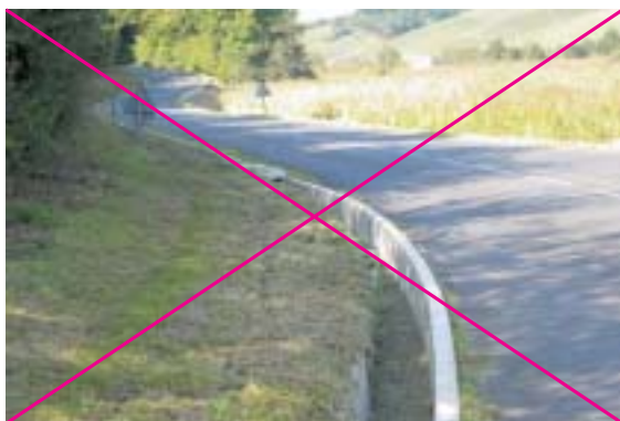
Figura 11.10 – Las zanjas de recogida de anfibios que los conducen a entradas de pasos ubicadas en su interior, constituyen trampas para animales de pequeño tamaño. Foto: C. Rosell.
