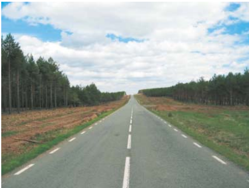
Figura 16.1 – Franja deforestada en los bordes de una plantación forestal que favorece la detección de ungulados presentes en los márgenes de la calzada. Esta medida se aplica en ocasiones para facilitar la lucha contra incendios. Foto: C. Rosell.
