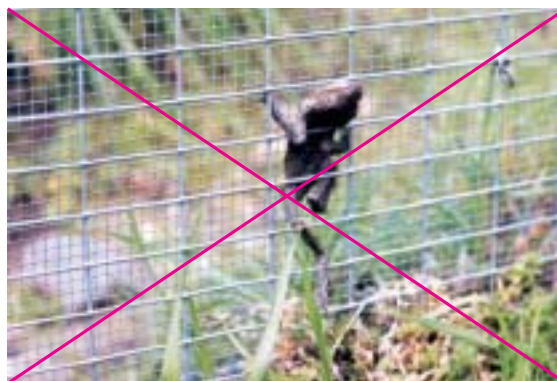
Figura 11.11 – Las mallas de alambre galvanizado no son aplicables porque los anfibios intentan trepar por ellas. Foto: R. Campeny.
