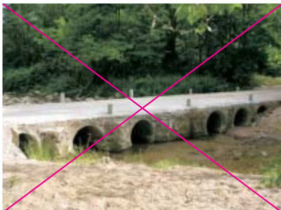
Figura 10.3 – Drenajes situados en un badén que dificultan el paso de peces. Foto: F. Navàs.
