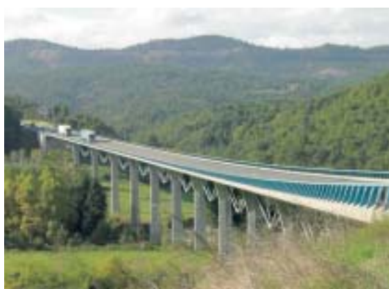
Figura 5.3 – El viaducto permite mantener la continuidad del curso fluvial y evita la fragmentación de las zonas de cultivo: Foto: C. Rosell.
