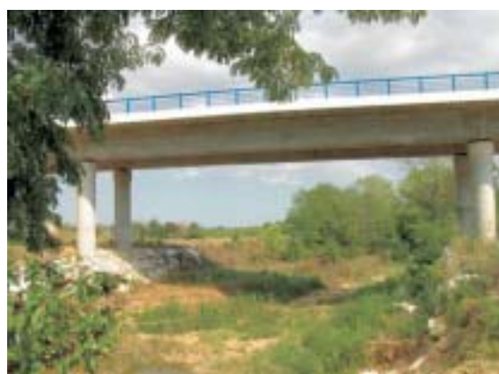
Figura 5.4 – Pilas situadas fuera del cauce. Foto: R. Campeny.
