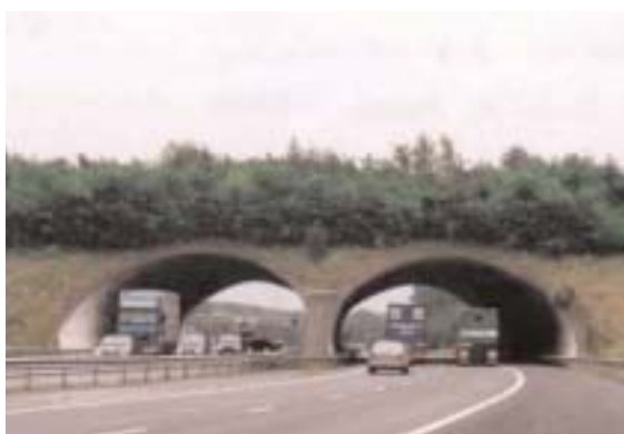
Figura 1.6 – Pantalla vegetal densa para reducir las perturbaciones generadas por el tráfico. Foto: V. Hlavac.
