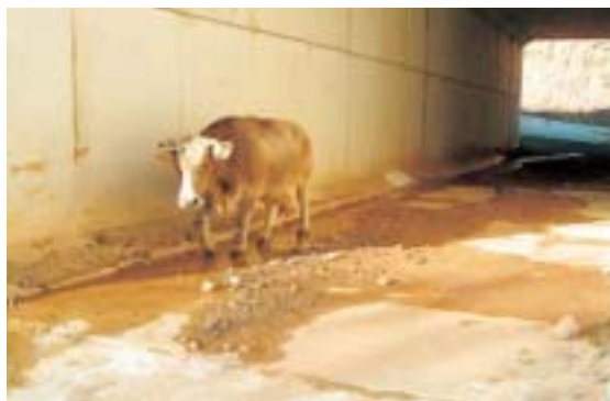
Figura 7.5 – Los pasos destinados a ganado también pueden ser adaptados para facilitar su uso para fauna silvestre. Foto: E. Perapoch.
