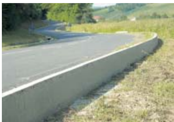
Figura 11.4 – Cerramiento opaco de hormigón que constituye una óptima estructura de guía. En este ejemplo faltan las barreras para garantizar la seguridad de los vehículos. Foto: C. Rosell.
