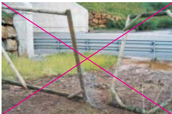
Figura 13.11 – La falta de mantenimiento facilita la entrada de animales en las vías. Foto: F. Navàs.
