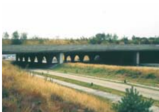
Figura 1.7 – Las motas en los márgenes laterales del ecoducto reducen las perturbaciones en su superficie. Foto: C. Rosell.
