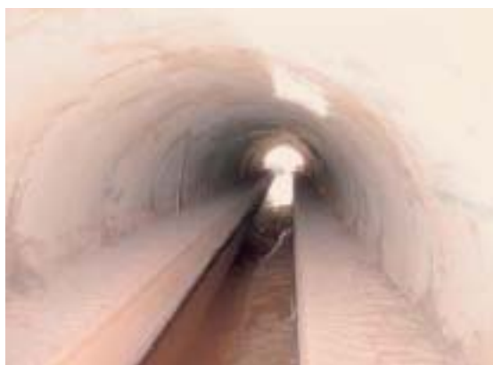
Figura 9.4 – Interior de una bóveda con plataformas laterales secas. Foto: F. Navàs.
