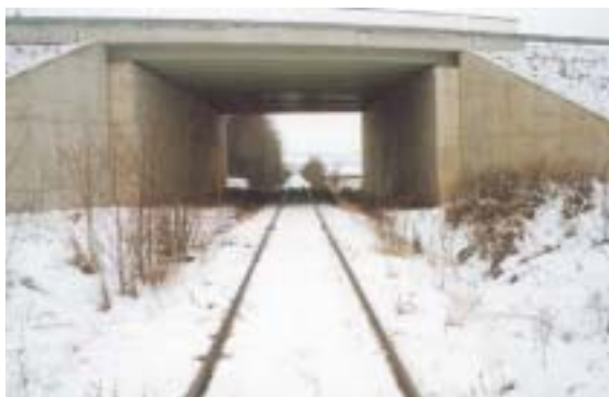
Figura 7.2 – Paso de una vía de ferrocarril que combina el paso esporádico de trenes con el de fauna. Foto: V. Hlavac.
