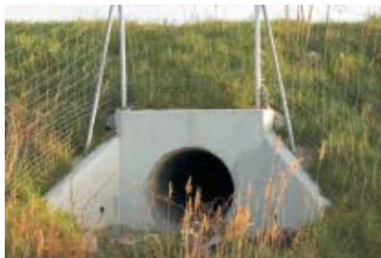
Figura 12.4 – Correcta instalación del cerramiento perimetral. Foto: F. Navàs.
