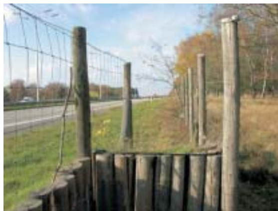
Figura 15.2 – Otra visión de una de las rampas en la que se aprecia su disposición respecto a la malla de cerramiento. Foto: C. Rosell.
