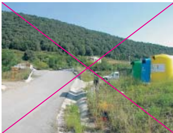
Figura 3.7 – Colocación de contenedores de residuos próxima a los accesos de un paso superior adaptado al paso de fauna. Foto: F. Navàs.
