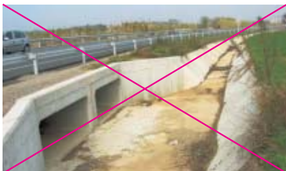
Figura 9.9 – Las paredes de la acequia dificultan el retorno de los animales al entorno. Foto: F. Navàs.
