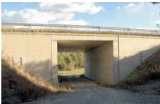
Figura 7.4 – El camino sin pavimentar y el cerramiento bien adosado a las aletas favorecen el paso de fauna. Foto: F. Nàvas.
