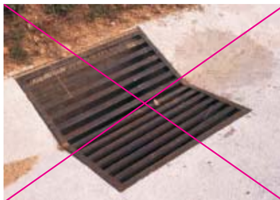
Figura 20.5 – Las rejillas protectoras deben ser muy densas para evitar la caída de pequeños animales. Además siempre es preferible que las paredes de las arquetas o pozos se adapten para facilitar la salida de animales. Foto: C. Rosell.
