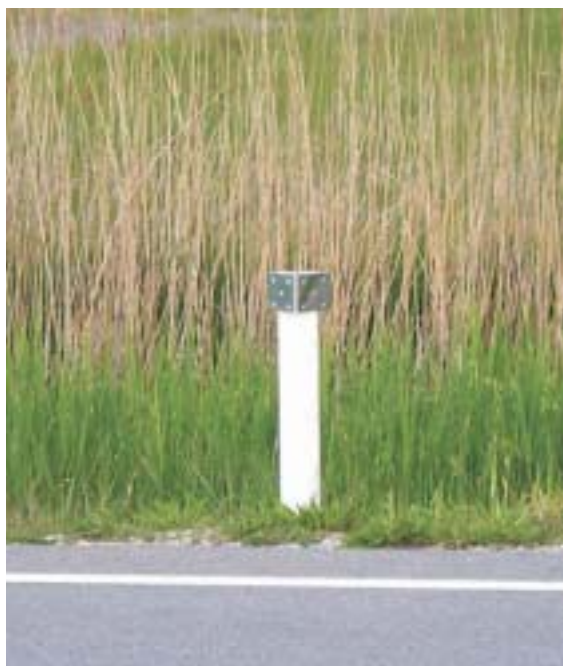
Figura 18.2 – Existen diversos modelos de reflectores utilizados para proyectar las luces de los faros hacia el entorno de la vía. Estos sistemas requieren tareas frecuentes de mantenimiento y su efectividad es temporal. Fotos: C. Rosell, J.M. Velasco.
