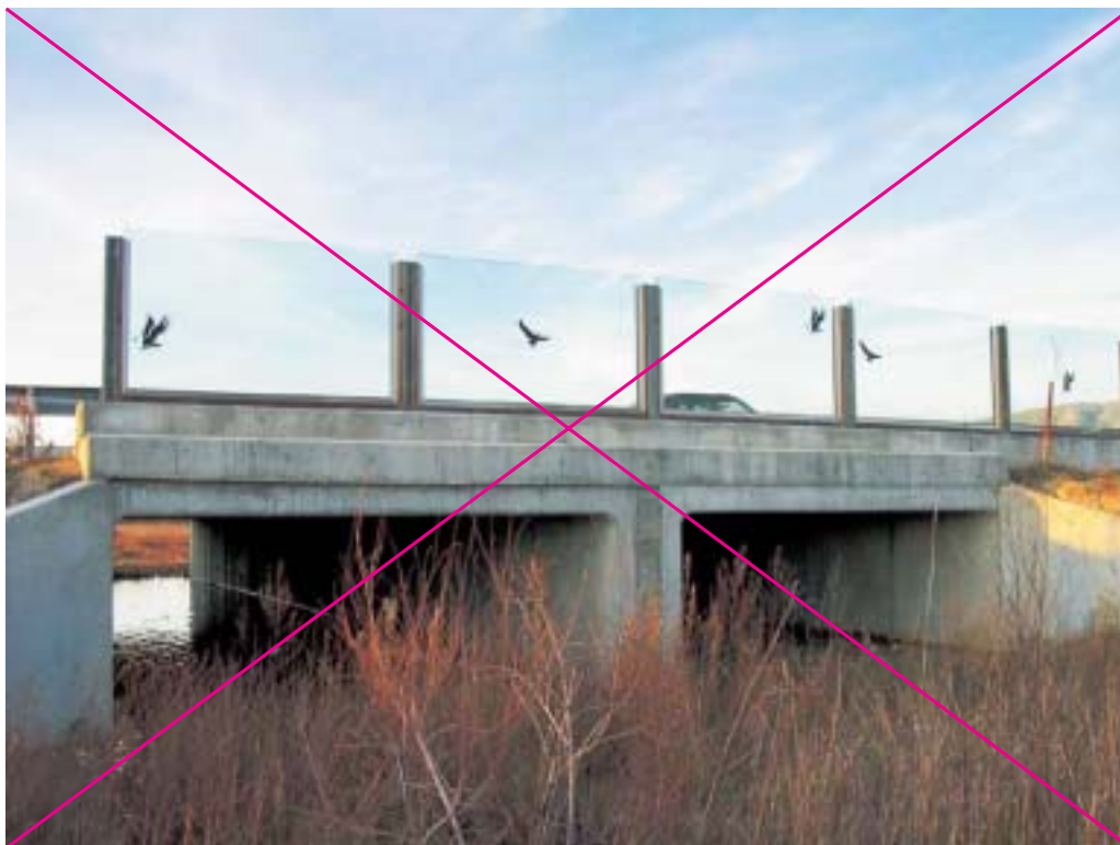
Figura 19.2 – Pantalla transparente con siluetas de rapaces que no son efectivas para impedir las colisiones de aves. Foto: F. Navàs.
