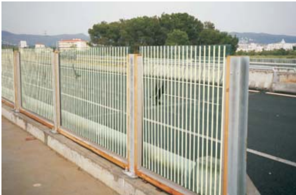
Figura 19.1 – Señalización de una pantalla acústica transparente a la que se han añadido bandas verticales para reducir el número de colisiones de aves. Foto: F. Navàs.
