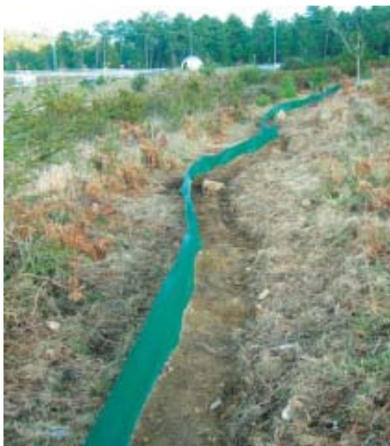
Figura 11.6 – Barrera temporal que se combina con cubos de recogida. Foto: Oficina de Medio Ambiente, Universidad de Vigo.
