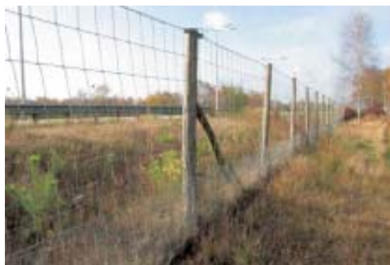
Figura 14.4 – Refuerzo de un cerramiento instalado para evitar el acceso de tejones y otros carnívoros a la calzada. Foto: C. Rosell.
