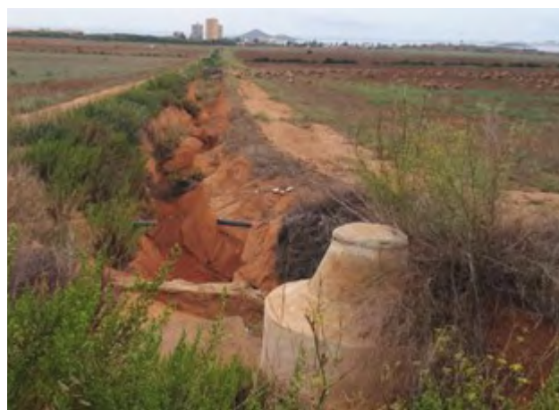
Figura 5. Estado actual de uno de los canales de drenaje agrícola existentes. Al fondo, Mar de Cristal y la laguna del Mar Menor.
