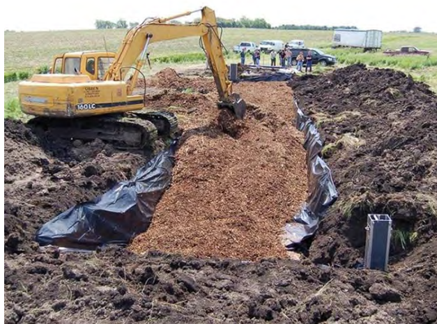
Figura 2. a) Construcción de biorreactores rellenos de contenedores de cemento con astillas en EE.UU. https://access.onlinelibrary.wiley.com/doi/full/10.1002/agg2.20149 ; b) Relleno de un biorreactor con virutas de madera para tratar efluentes de acuicultura en EE.UU. (fotografía de L. Christianson/Iowa Soybean Association Environmental Programs and Services; https://www.globealseafood.org/advocate/woodchip-bioreactors-effectively-treat-aquaculture-effluent/ ).
