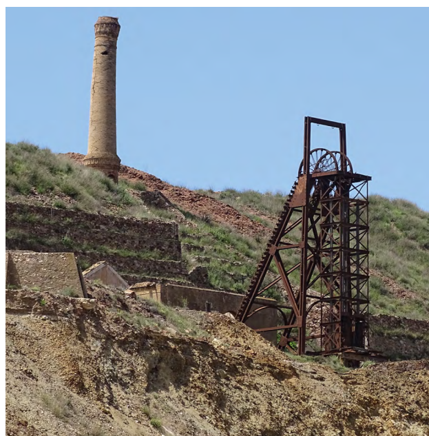
Figura 7. Castillete, salas de máquinas y de calderas, y chimenea de la Mina Montserrat. Cabezo Rajao.
