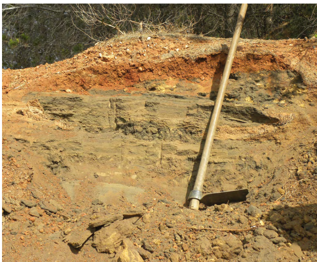
Figura 3. Imagen que muestra la parte superior de uno de los taludes de la presa minera conocida como Pajarillos. Puede observarse una capa de tierra arcillosa rojiza que recubre los residuos mineros.
