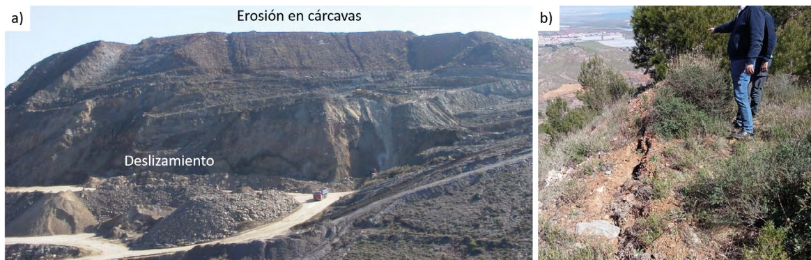
Figura 10. Riesgos geotécnicos-estructurales en las escombreras de estériles mineros, a) deslizamiento y erosión en cárcavas en las escombreras Los Blancos, b) grietas de tracción en la cabecera del talud de la escombrera bajo los aerogeneradores SMCLU, parte alta de la cuenca que limita con la presa el Descargador I.
