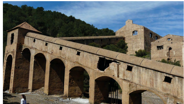
Figura 8. Lavadero El Lirio, conjunto minero de Ponce.
