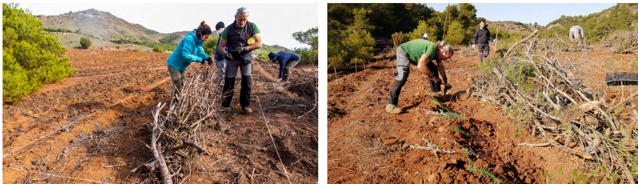
Figura 4. Izquierda: construcción de fajinas forestales. Derecha: plantación. Estas labores se realizaron con la ayuda de la Fundación Sierra Minera.
