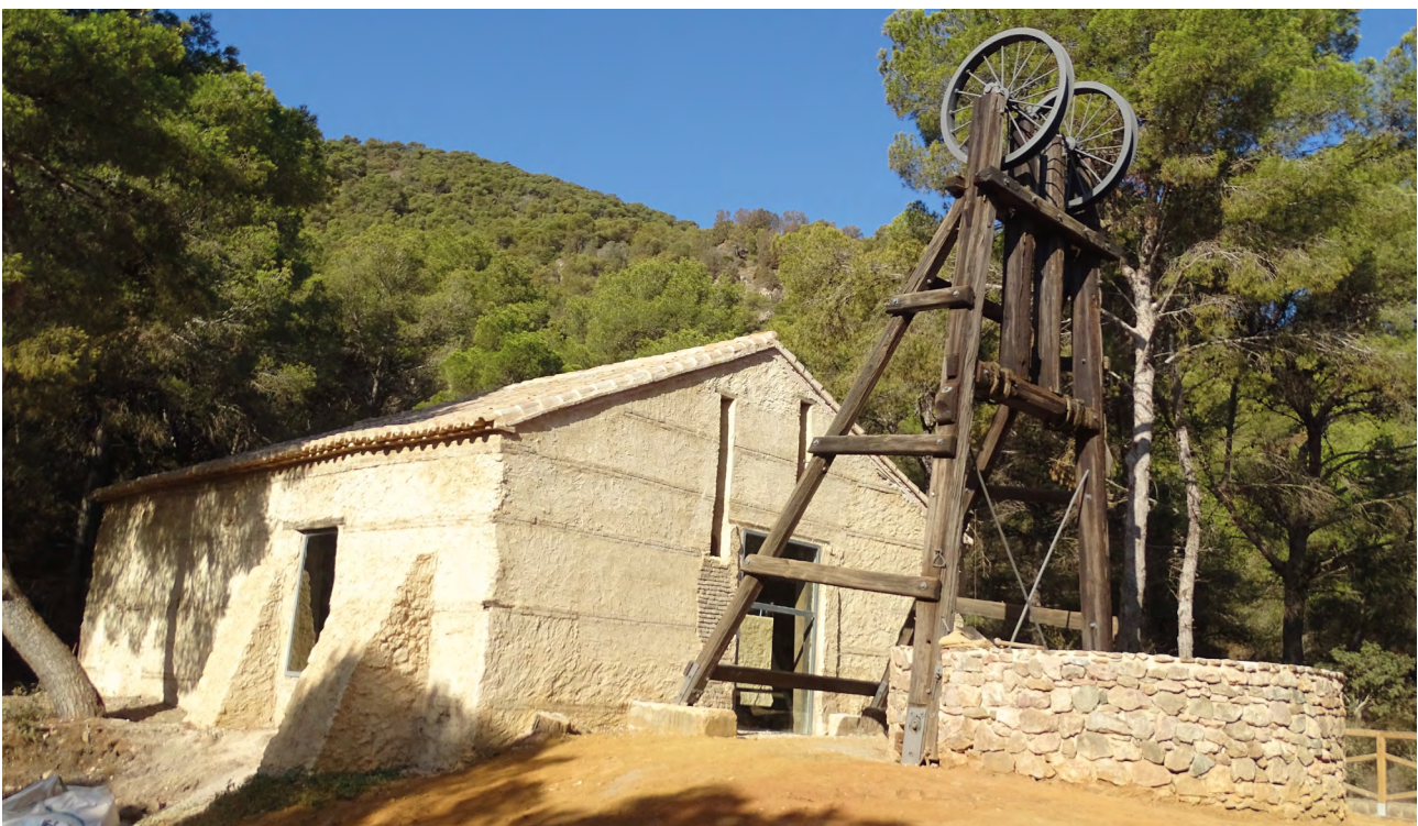
Figura 9. Castillete y casa de máquinas de la Mina Santo Tomás restaurados.
