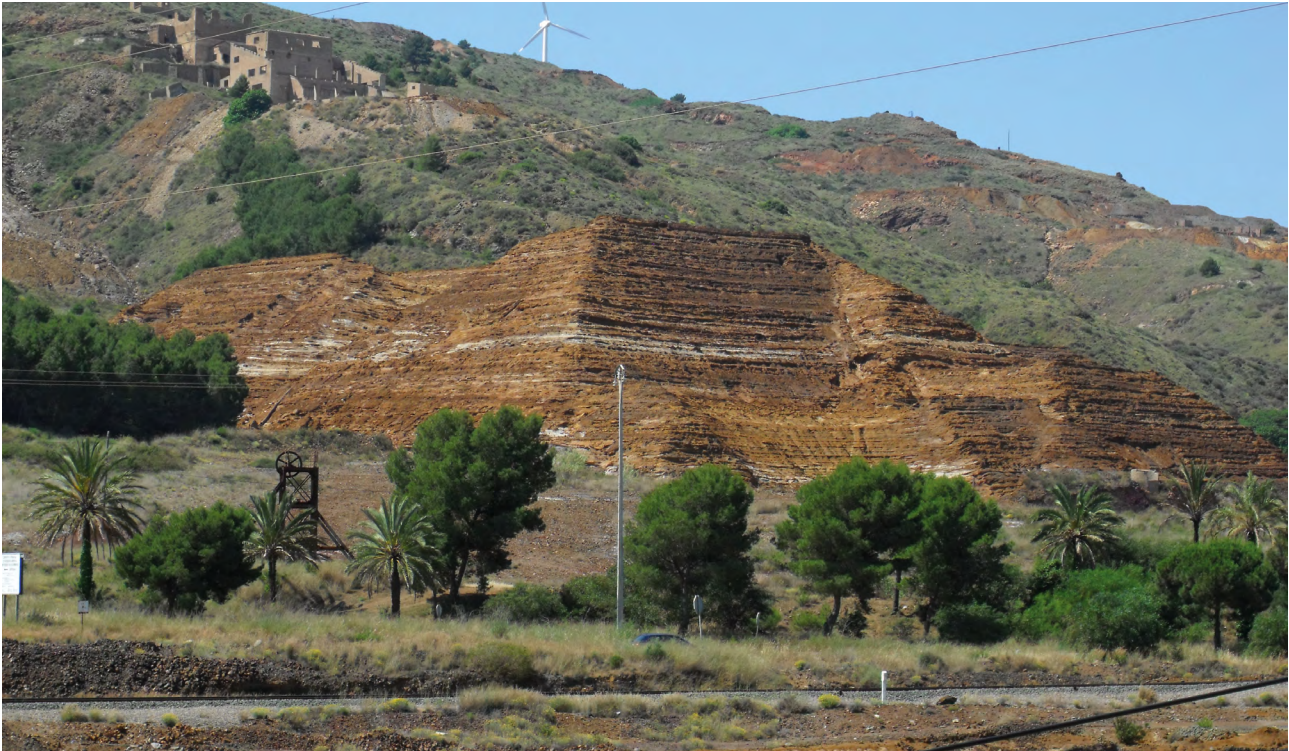
Figura 2. Presa minera conocida como Descargador I desde una posición que permite apreciar el tamaño de la misma, con una altura máxima de 40 m.
