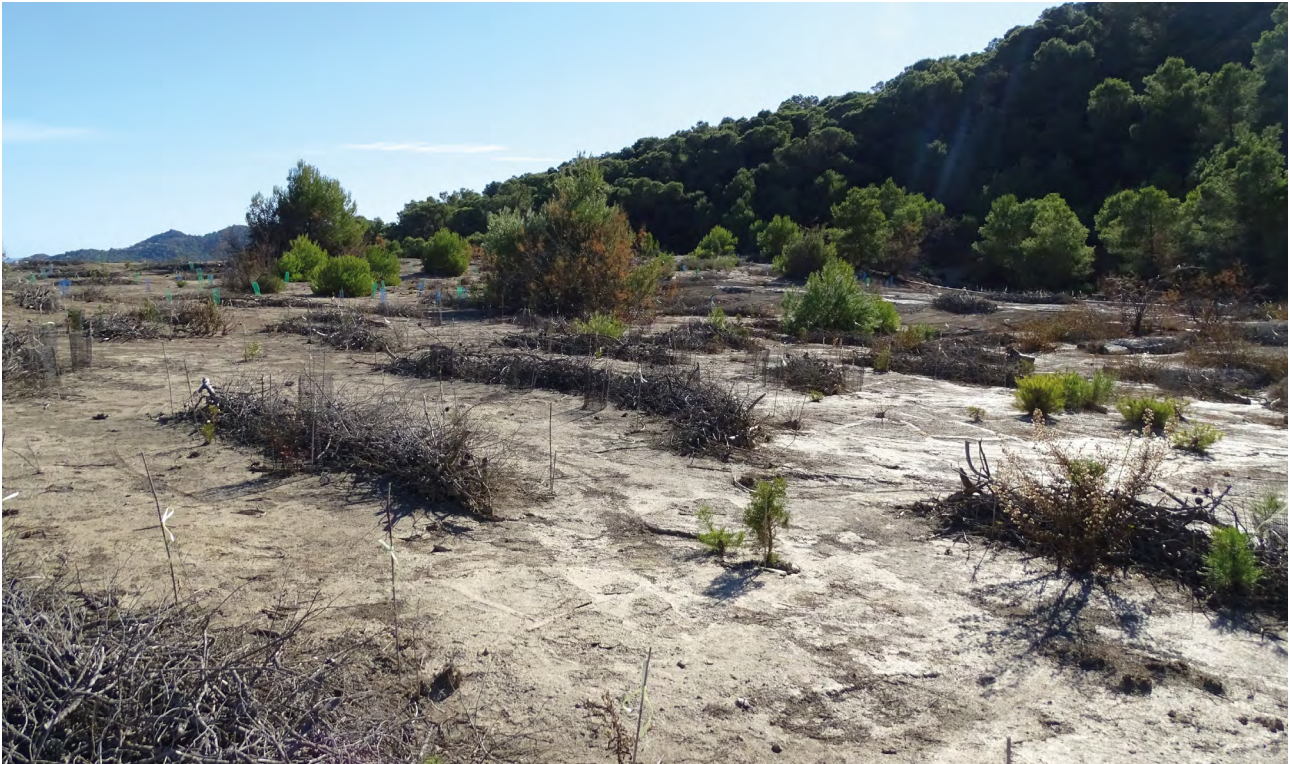
Figura 10. Fitoestabilización en la balsa de estériles de Peña del Águila II, con fajinas. Proyecto Life Tetraclinis.
