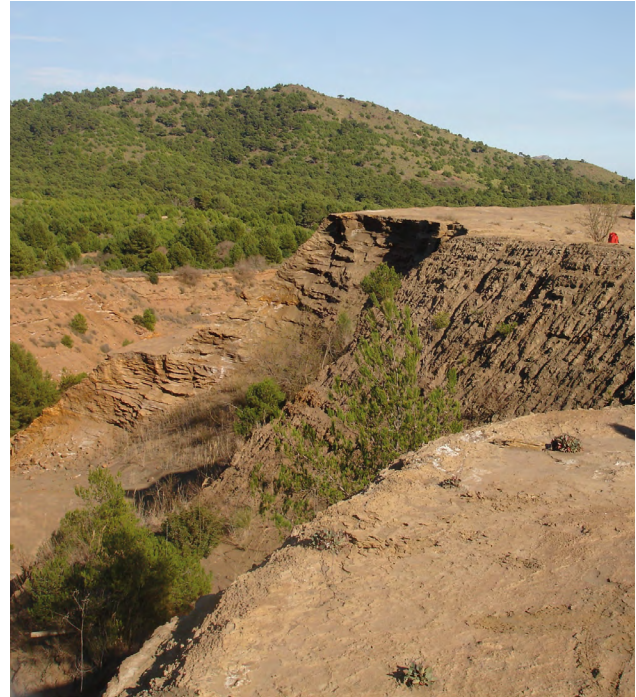
Figura 6. Fotografía de la presa minera conocida como Mercader en el año 2011. En la actualidad se encuentra sometida a experiencias de implantación de vegetación ejecutadas con posterioridad.
