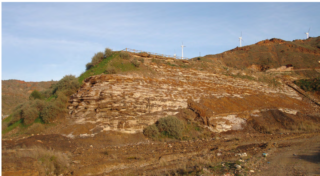
Figura 4. Presa minera de la Cuesta de las Lajas, observándose un talud de perfil recubierto de tierras y vegetación y otro, de frente, con profusión de sales blanquecinas de sulfatos.
