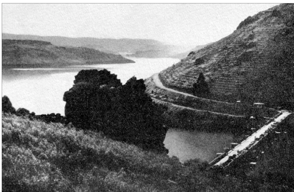
Figura 249. Repoblación de las laderas del embalse de Cijara, en 1958. Estas actuaciones eran imprescindibles para regularizar el régimen hidrológico de los arroyos del contorno, minimizar el aporte de finos a los embalses y alargar su vida útil, retrasando su colmatación.
