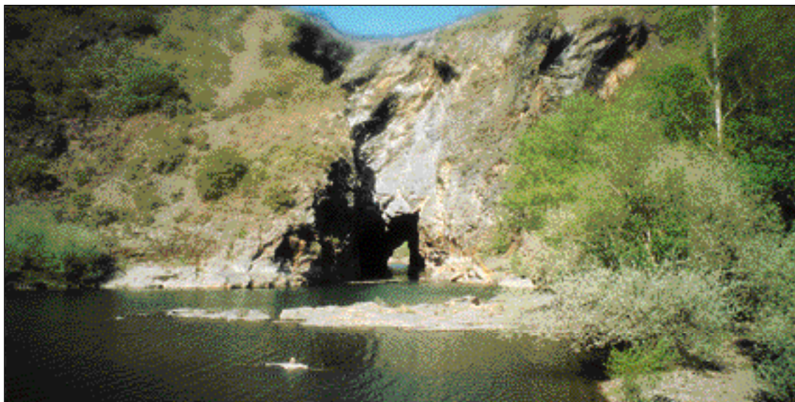
Fotografía 23: En el área gallega es conocida la construcción del túnel de Montefurado, de tiempos romanos, en el río Sil (en la imagen). Parece tratarse de la excavación de un túnel que, situado en la base de un meandro, permitiría desviar el curso de agua para el lavado de las arenas auríferas (Luis Gil).
