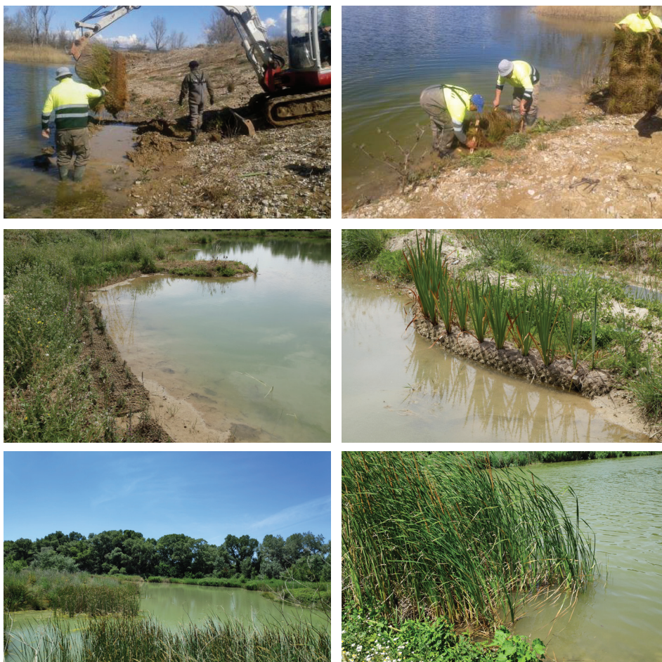
Figura XIII.18. Colocación de mantas y biorrollos con especies de helófitas (fotos: E Berian). En las dos fotos inferiores puede verse el buen estado de estas plantaciones en el año 2020 (fotos: M Goikoetxea).
