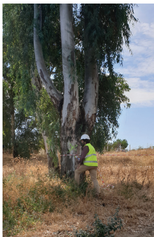
Realizando la comprobación del replanteo de una obra (foto: CH Guadiana).
