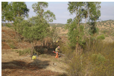
Figura 24.14. Labores de desbroce manual con motodesbrozadora en las inmediaciones de la presa del Andévalo sobre Cistus ladanifer , según lo indicado en el proyecto (foto: CH Guadiana).
