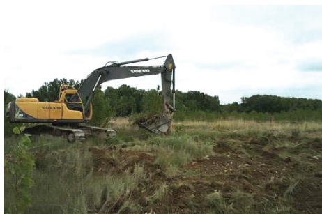
Destoconado mediante excavación con cazo.
