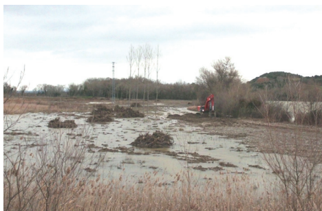
Trabajos de eliminación de la mota y efectos de la avenida del río Aragón.
