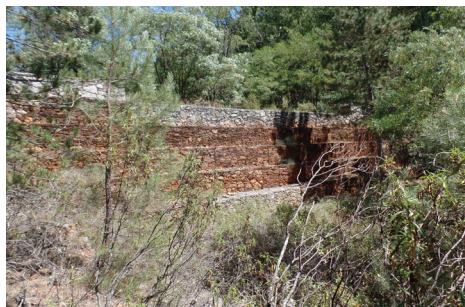
Dique de cierre del Arroyo de Valdelabadía en 2016 (foto: R Serrada).
