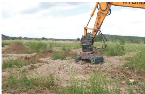
Extracción del tocón mediante cuchara de dos valvas.
