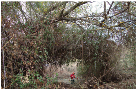
Labores de desbroce manual con motodesbrozadora.
