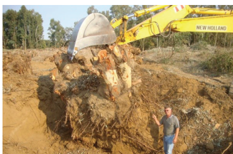
Operación de destocoado de eucaliptos.
