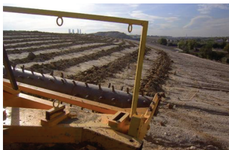
Figura II.3. Detalle de los procedimientos de preparación del suelo en la plantación del Parque Valdebebas. Se observa la labor de subsolado y el paso de un rulo (foto: J Sandoval).
