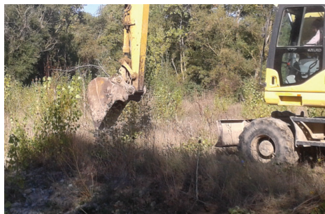
Figura XIII.6. Eliminación de rebrotes de chopos mediante extracción con el cazo de la retroexcavadora (foto: M Goikoetxea).
