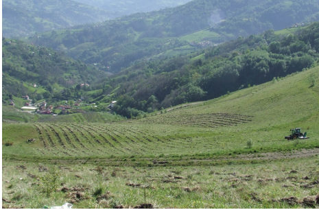
Preparación del terreno mediante subsolado lineal en máxima pendiente con tractor agrícola.
