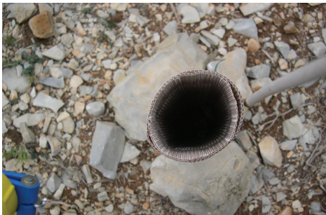
Doble tubo por falta de atención al extraerlo.
