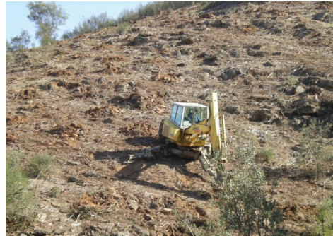
Se debe comprobar la densidad de los hoyos practicados, en este caso los efectuados por la retroaraña en pendiente, con objeto de lograr la densidad de plantación fijada en el proyecto.
