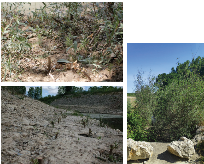
Figura XIII.16. Estaquillado con sauce en las orillas y estado de la restauración en 2020 (fotos: E Berián).
