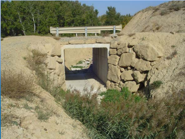
Encachado de piedra en desembocadura del Barranco de la Torre
