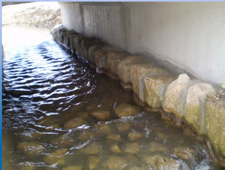
Detalle de orilla creada con piedras de escollera
