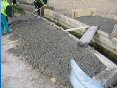
HORMIGONADO En zonas planas
