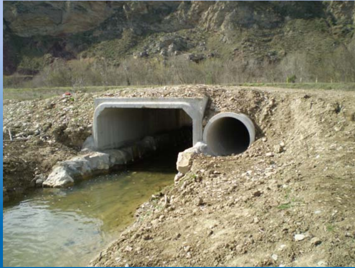
Combinación de repisa lateral y tubo seco
