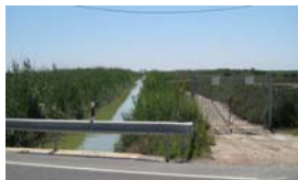
Fig. 7.4. Canal del Km. 82.850. Se observa el camino de entrada sin asfaltar con valla de entrada. El vallado no llega ni al agua ni a la carretera.
