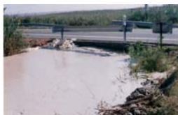
Fig. 7.5: El mismo canal después de unas lluvias intensas.
