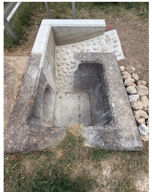
A la izquierda, se indica el ámbito de actuación del proyecto en cursos de agua (naranja) y carreteras (rojo). A la derecha, detalle de las obras realizadas en un pozo de salida de un drenaje que se ha acondicionado.
