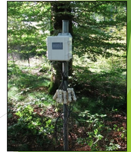
Sondas humedad y temperatura del suelo
