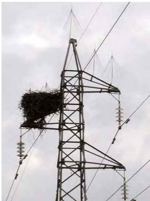
Disuasores de posada instalados en tendido para evitar la electrocución de aves
