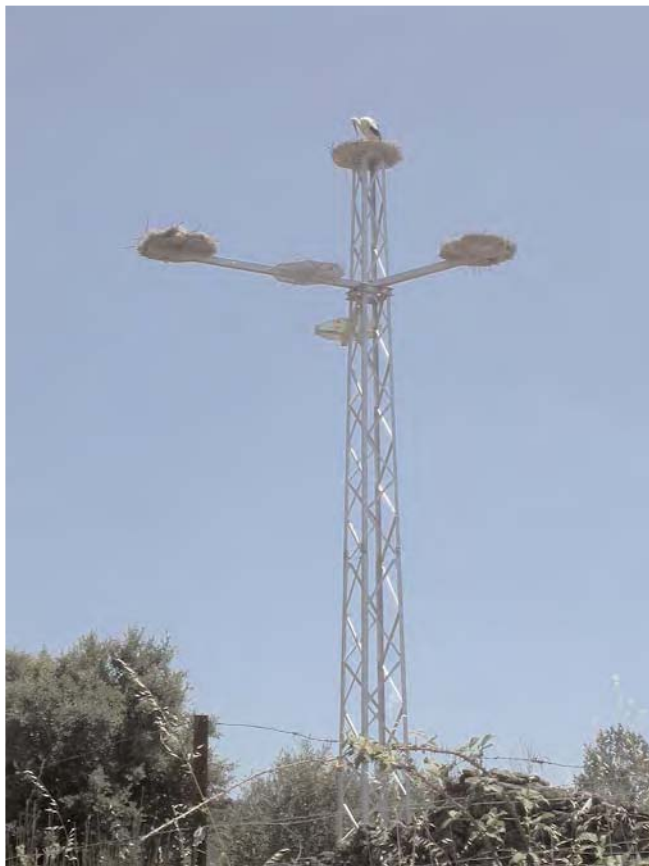
Torreta sin conducción eléctrica colocada para su uso como lugar de nidificación
