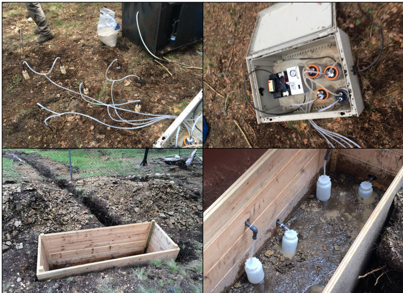
FIG 45: Lisímetros de tensión para extracción de agua del suelo y bomba de vacío. Lisímetro de gravedad, zanja de drenaje y toma de muestras.
