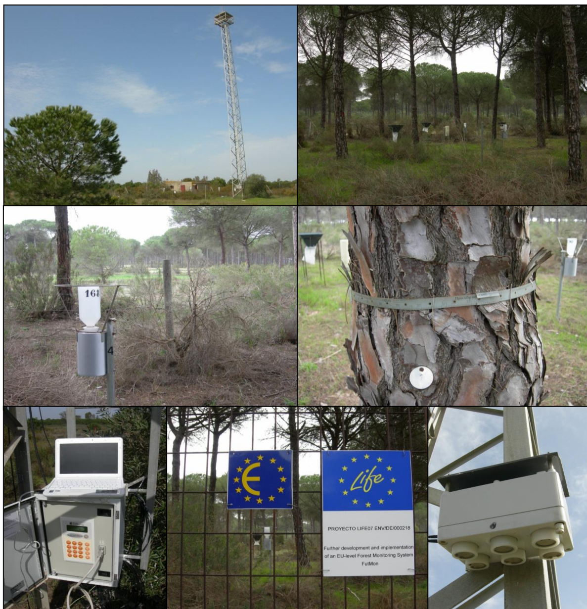
FIG 7 : Torre meteorológica. Parcela interior. Acumuladores de deposición. Dialdendro. Data-logger. Dosímetros pasivos
