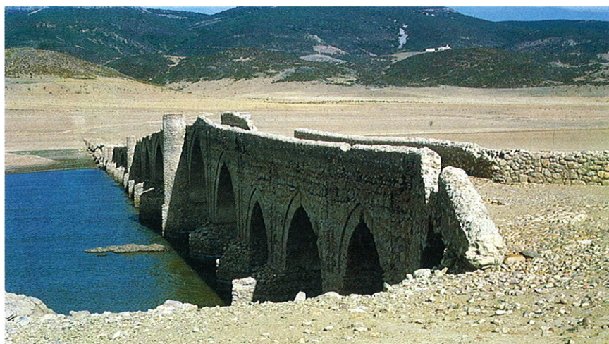
21. Puente merinero sobre el río Guadiana, que permitía el paso y recuento de rebaños en la Cañada Real Segoviana. Villarta de los Montes (Badajoz).
