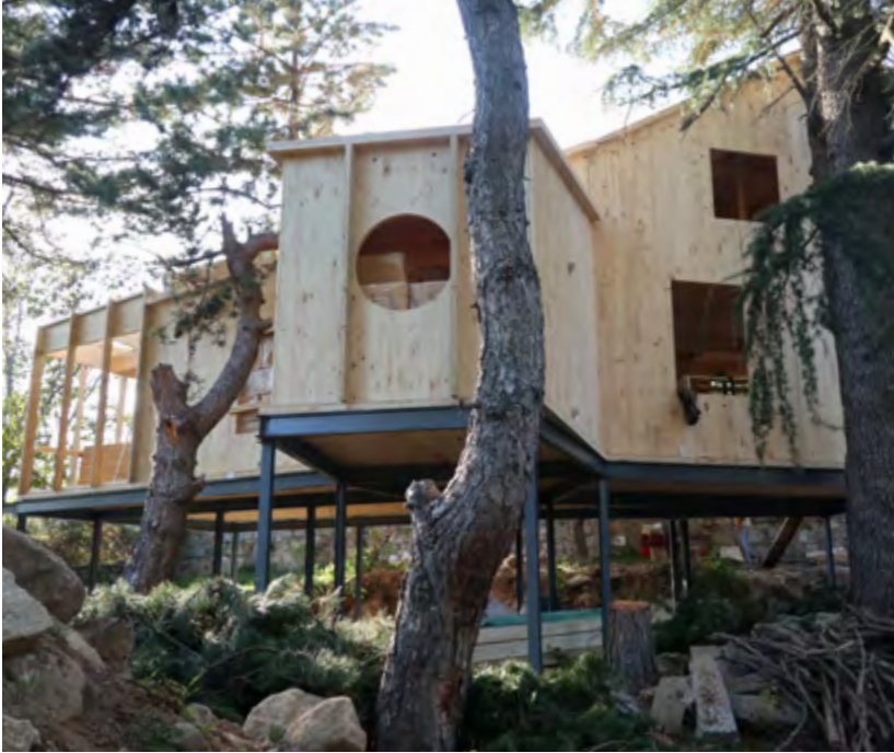
Foto. Máquina Líquen. Fase de montaje de los paneles estructurales de madera CLT (fachada este) desplegándose entre árboles, con la cabaña de las niñas en el centro y una ventana de ojo de buey
