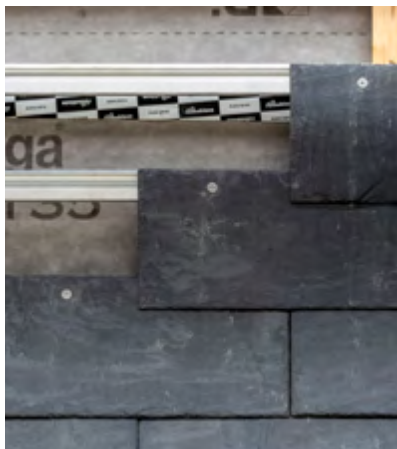
Figura 8: Fachada ventilada de pizarra. Detalle durante el montaje (izq.) y aspecto exterior del edificio una vez terminada su colocación (dcha.). Fotografías: Héctor Santos-Díez.
