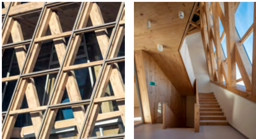
Figura 10: Celosías de fachada. Celosía sur, detalle desde el exterior (izq.), y celosía norte, aspecto desde el interior (dcha.). Fotografías: Héctor Santos-Díez.
