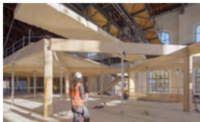
Foto. Rubén Pérez Bescós. Colocación de pieza de forjado -CLT de 13 x 2 m- utilizando el puente grúa.
