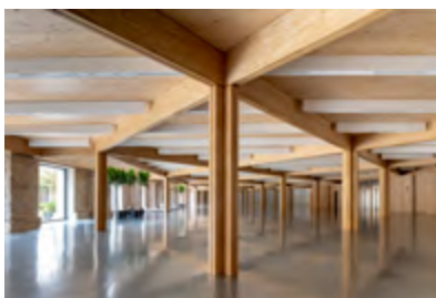
Foto. Foster + Partners. Vista interior de la planta sótano. La estructura insertada dentro del espacio está hecha de madera de origen sostenible, procedente de bosques locales que posibilita una flexibilidad espacial.
