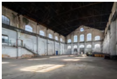
Foto. Foster + Partners. Estado previo a la obra. Interior de la nave.
