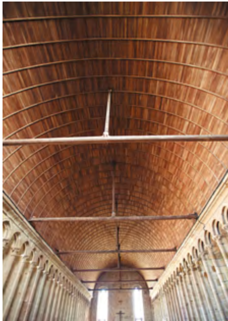
Foto 1. Estructura de grandes dimensiones y bajo consumo de material en madera (Michael Foley 2013, Wooden Ceiling / Flickr).
