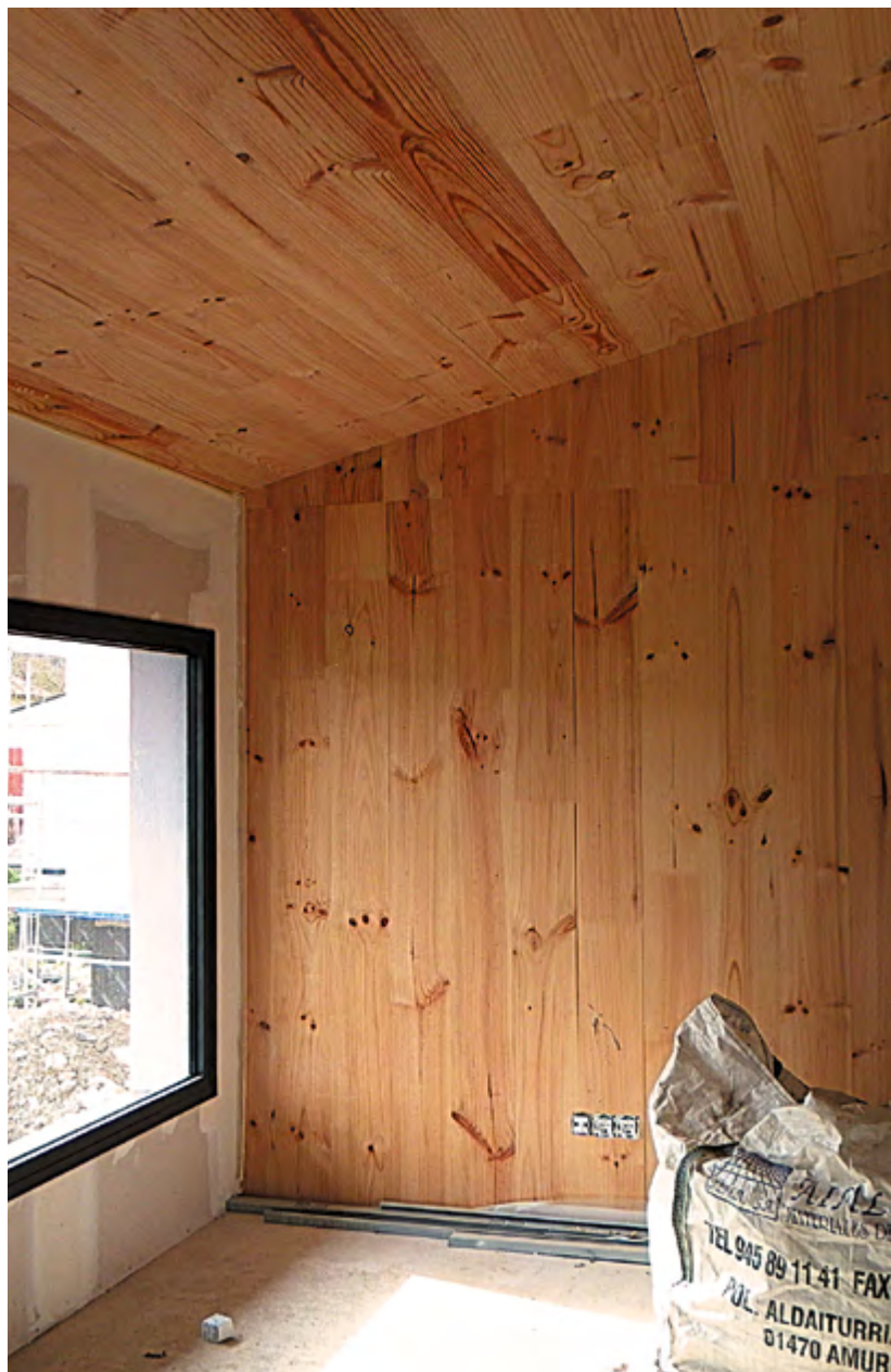
Foto 4. Acabados interiores vistos sin necesidad de trasdosado. Casa Odel. Estudio de arquitectura mycc.
