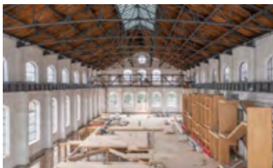
Foto. Rubén Pérez Bescós. Vista del interior de la nave durante el proceso de montaje de la estructura de madera. A la derecha, pantallas estructurales de CLT para los núcleos de ascensores, patinillos y escaleras. Al fondo, puente grúa original del edificio, utilizado para el montaje de la estructura de madera.
