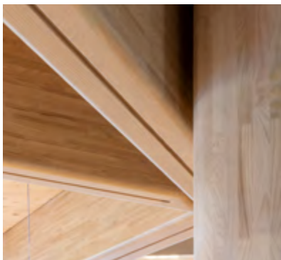
Foto. Foster + Partners. Detalle de la estructura de madera
