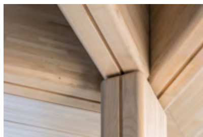
Foto. Foster + Partners. Detalle de la estructura.
