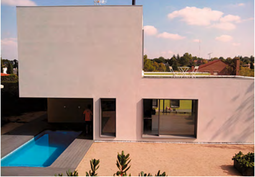
Foto 1. Voladizo de la planta primera sobre piscina. Casa Marbel. Estudio de arquitectura mycc.
