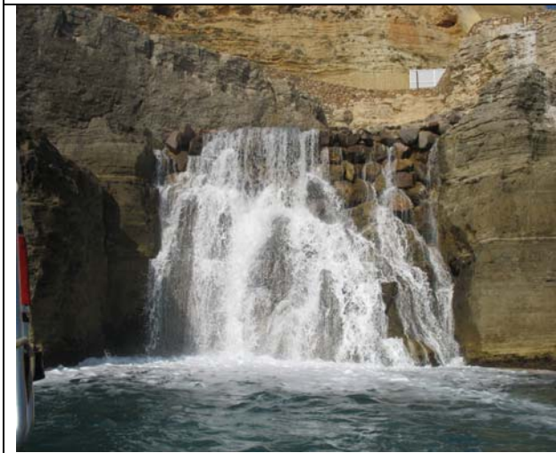
Rebose sobre un acantilado. Desaladora de Melilla
