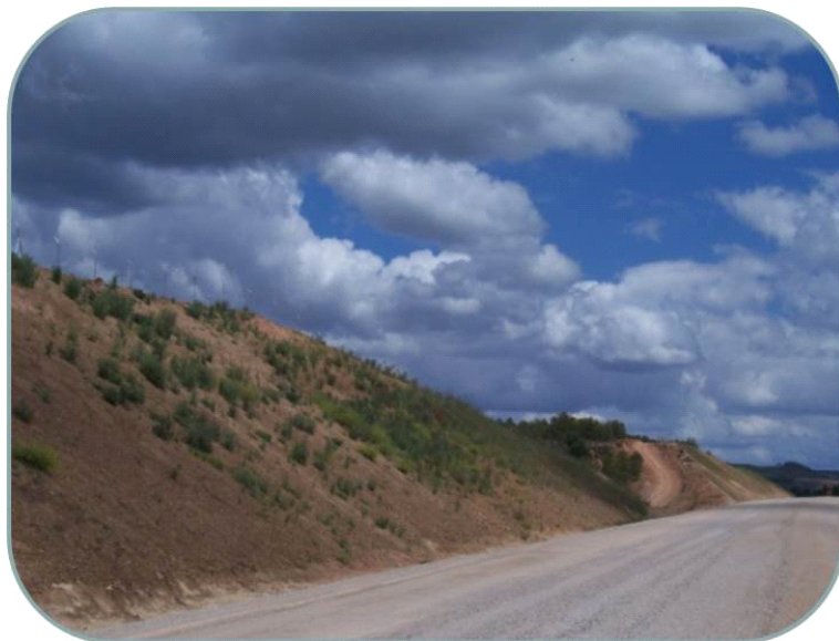
Figura 3. Talud de desmonte cubierto por especies herbáceas de la zona.
