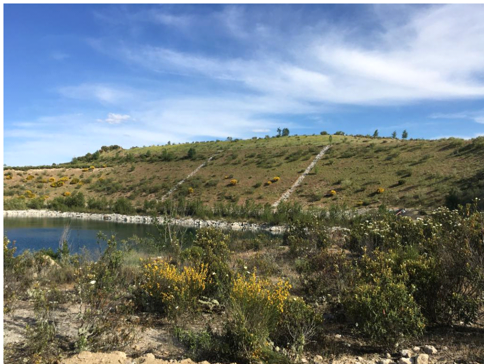
Figura 9. Panorámica del talud en abril de 2017.
