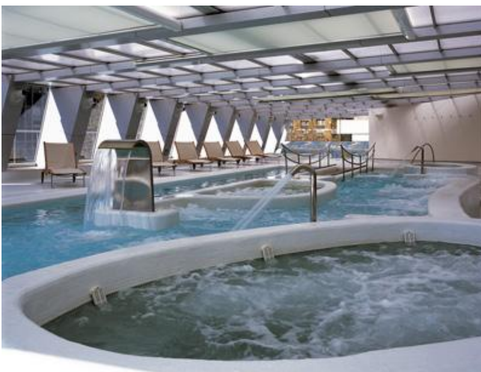
Foto 3.9. Instalaciones de spa en el hotel Eurobuilding (Fuente: NH Hoteles).
