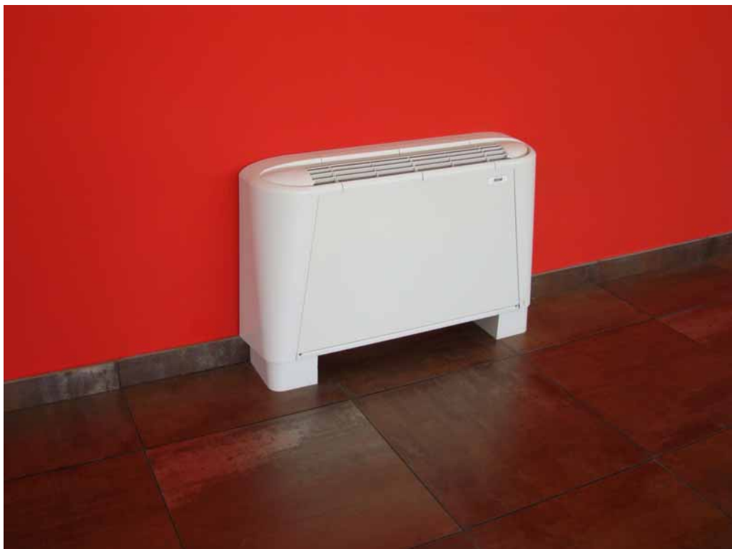
Foto A2.4. Equipo fancoil de pared (Fuente: Ferrol).
