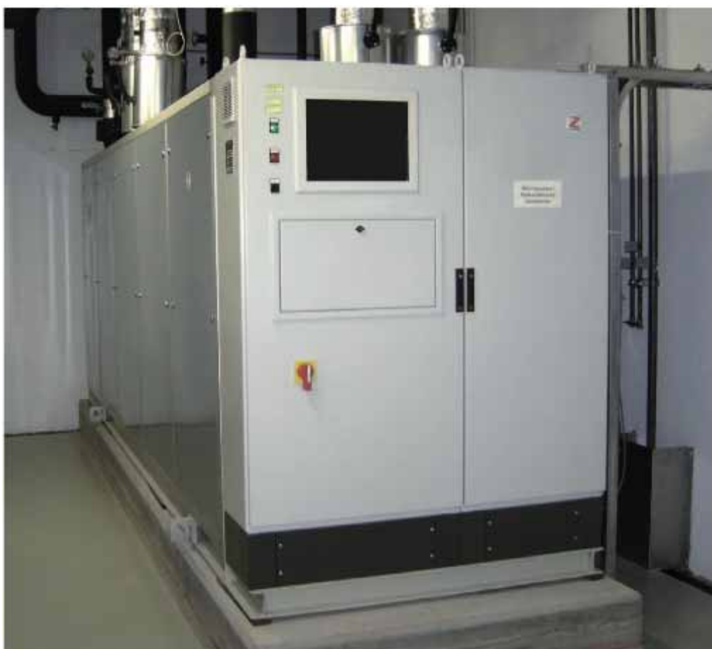
Foto A1.6. Bomba de calor geotérmica-unidad central de energía geotérmica Geozent profi (Fuente: Zent-Frenger).
