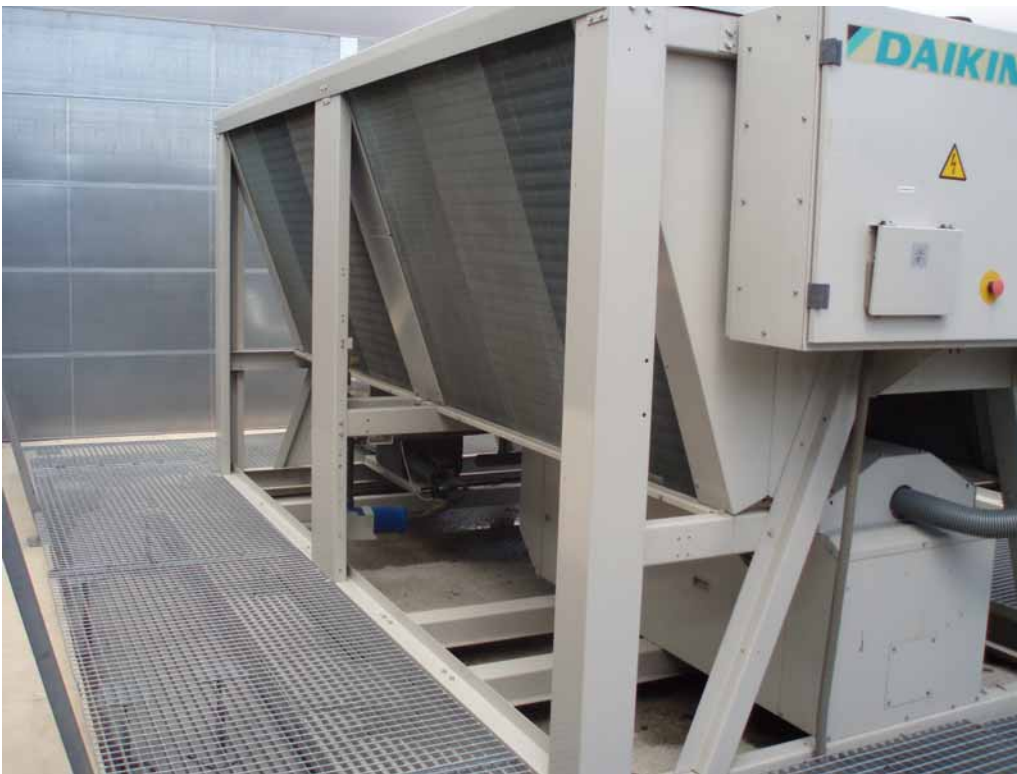
Foto A2.11. Equipo VRV ( Variable Refrigerant Volume ) instalado en el hotel Madrid Norte (Fuente: Rafael Hoteles).
