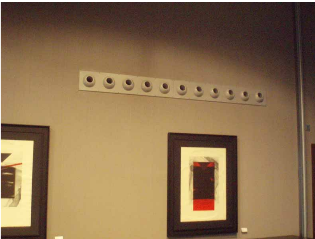
Foto A2.8. Toberas difusoras de aire en un salón de conferencias del Hotel Madrid Norte (Fuente: Rafael Hoteles).
