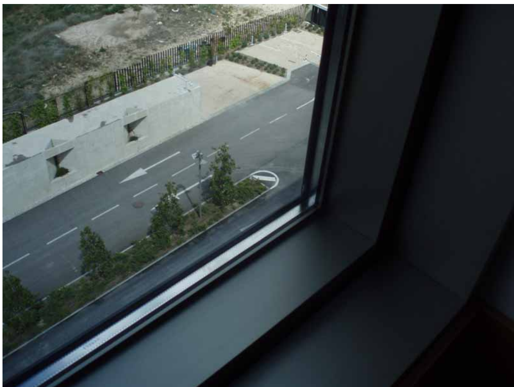
Foto A2.7. Detalle de rotura de puente térmico en el cerramiento del hotel Madrid Norte (Fuente: Rafael Hoteles).
