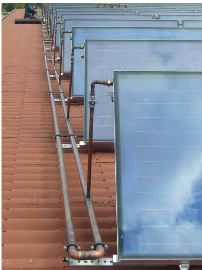
Foto A1.13. Ejemplo de instalación solar térmica (Fuente: Ferrolí).
