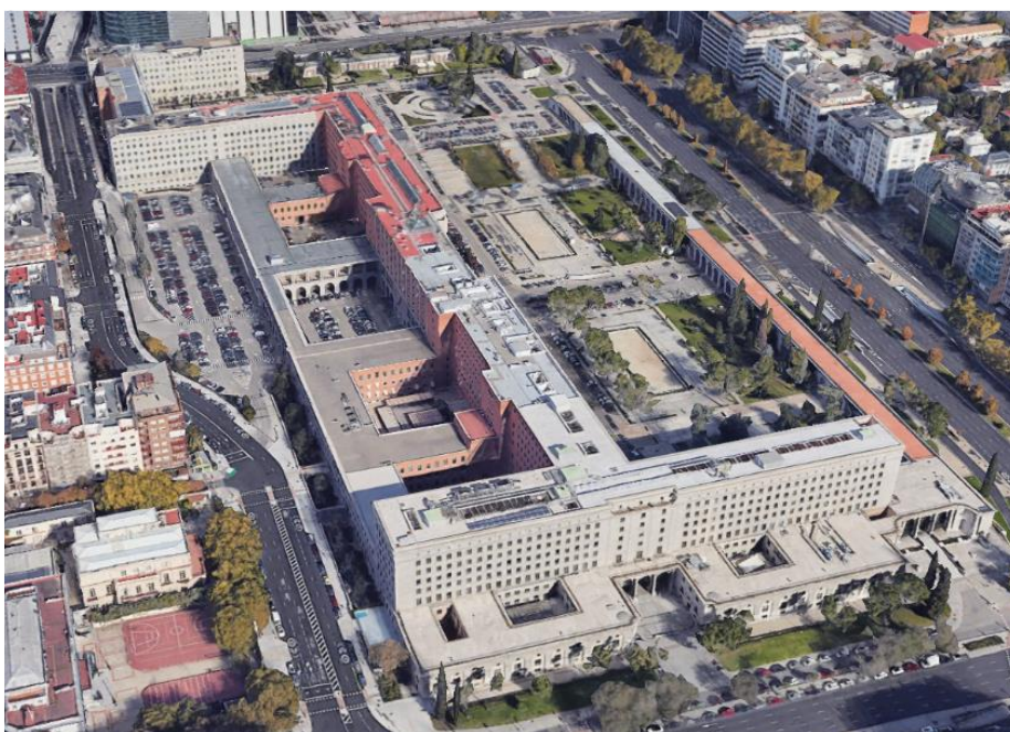
Imagen 1. Vista Aérea del complejo de Nuevos Ministerios
