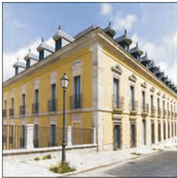
Exteriores del Parador de La Granja
