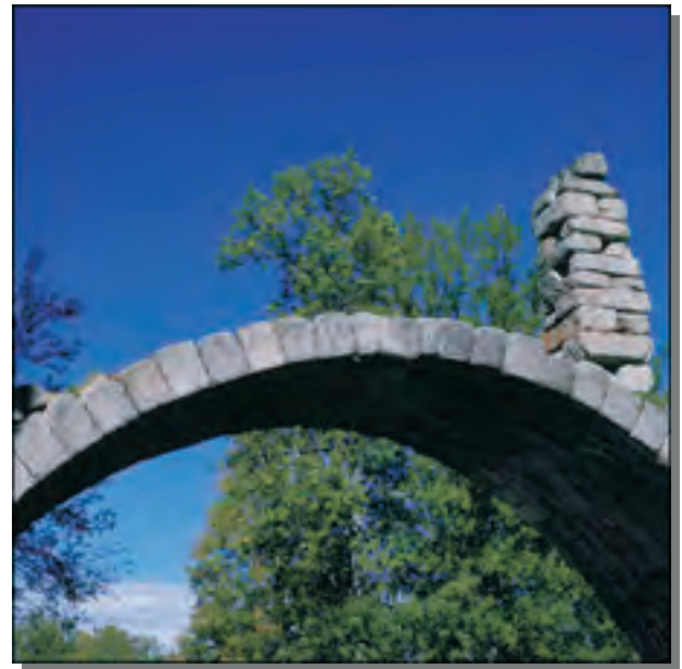
Puente de los Canales sobre el Rio Eresma
