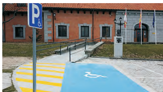
Acceso adaptado al edificio principal
