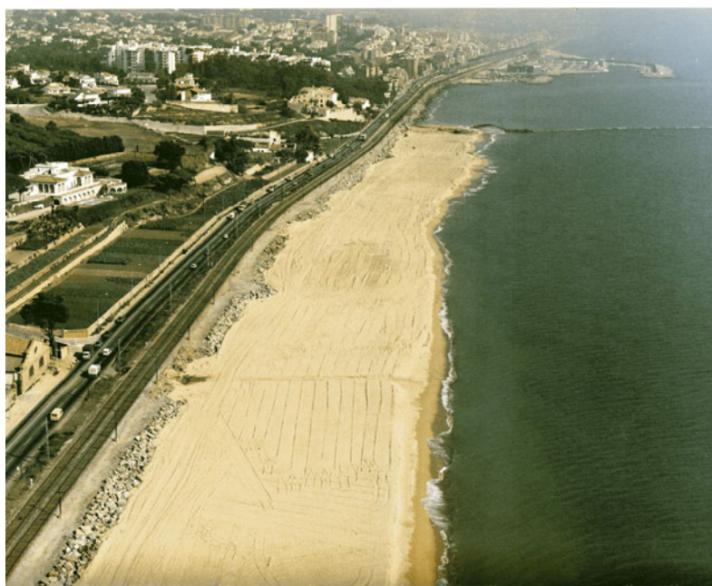
Figura 1.9: Regeneración de la playa de Mongat de la publicación de Actuaciones 1986 de la Dirección General de Puertos y Costas
